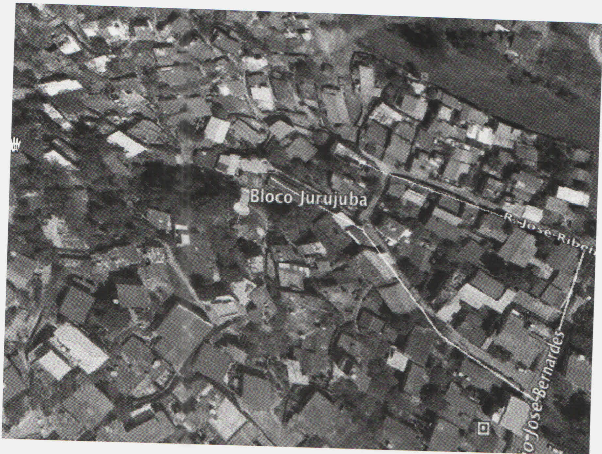
Figura 1 – Localização da área a ser estabilizada.
