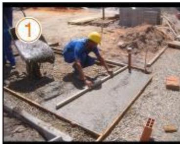
**Sarrafeamento do Concreto** – Imediatamente após o adensamento deve começar a operação de sarrafeamento do concreto, realizada com régua metálica e movimento de vaivém, até que se obtenha uma superfície plana. O atraso desta etapa comprometerá todas as demais.
