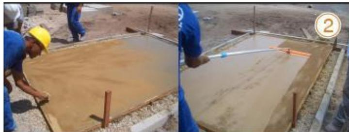
**Aplicação do Desmoldante** - Após a fixação do endurecedor, o desmoldante deve ser lançado manualmente, cobrindo por completo a superfície já queimada (A função desse componente é isolar a superfície de concreto, podendo ser utilizado para obter uma cor secundária). O desmoldante é lançado na superfície quando o concreto assumir o ponto de plasticidade ideal, antes do início de pega.
