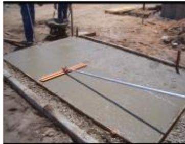
**Aplicação do Endurecedor de superfície colorido** - Após a camada de concreto ser trabalhada, faz-se a aspersão manual do pigmento endurecedor, de maneira a cobrir uniformemente toda a superfície.
