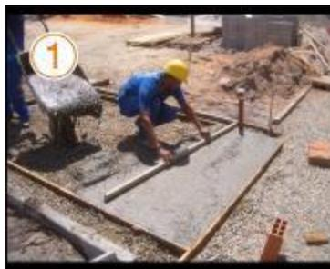
**Sarrafeamento do Concreto** – Imediatamente após o adensamento deve começar a operação de sarrafeamento do concreto, realizada com régua metálica e movimento de vaivém, até que se obtenha uma superfície plana. O atraso desta etapa comprometerá todas as demais.
