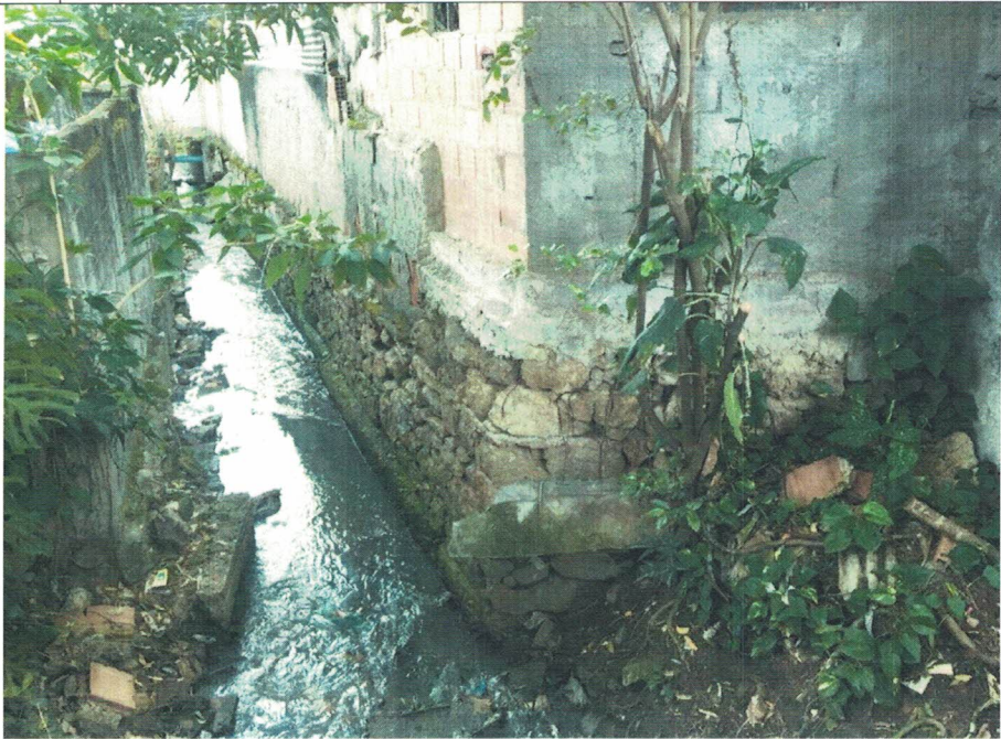
Figura 4 – Muro do canal no trecho em estudo.
