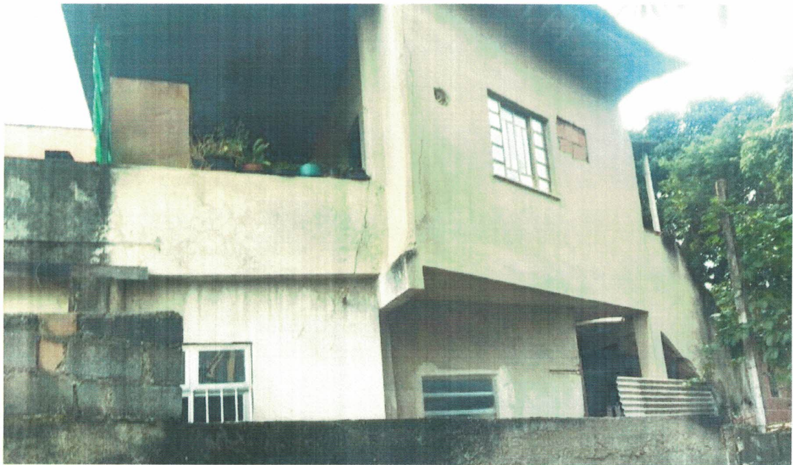
Figura 2 – Vista da lateral direita da construção.
