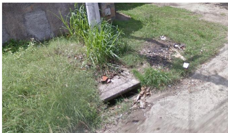
Figura 2 – Boca de lobo danificada.
