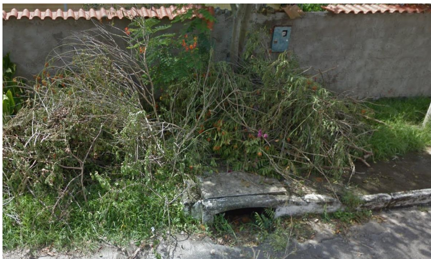
Figura 1 – Boca de lobo assoreada.
