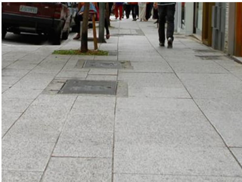
Figura 2. Pavimento de Placas de Concreto Pré-moldado de 40x40x6cm
