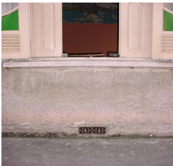
IMAGEM 02 – VENTILAÇÃO PORÃO ALTO BASE DE PAC
