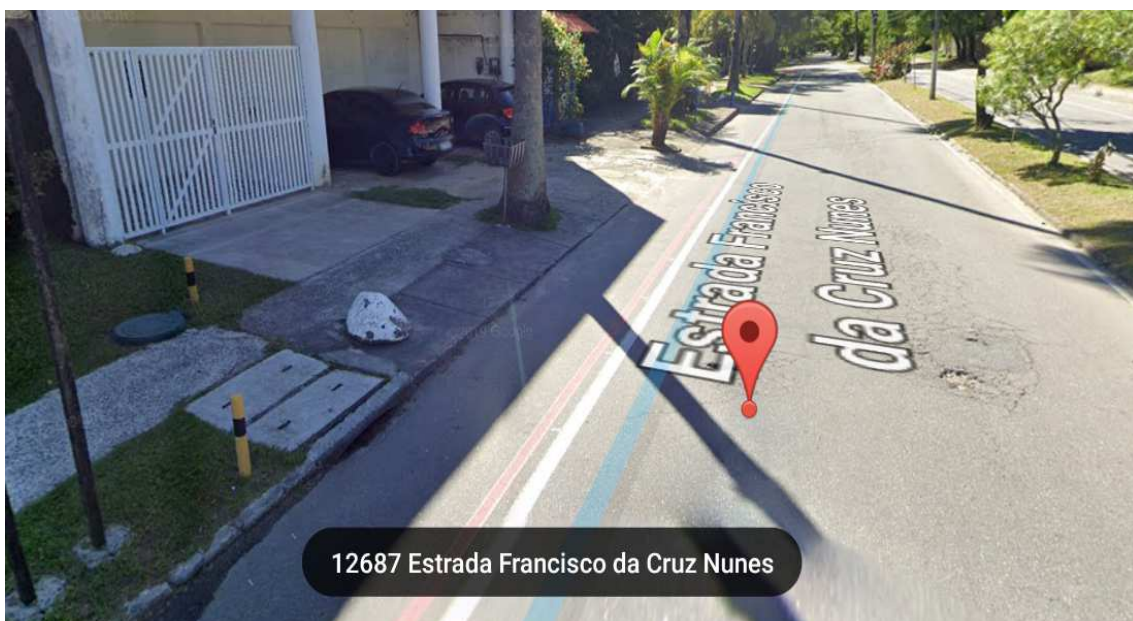
Foto 16 : Detalhe do sistema adotado em quase toda a drenagem local, boca de lobo e caixa (sem ramal) PV C- 04 em frente ao número 8512
