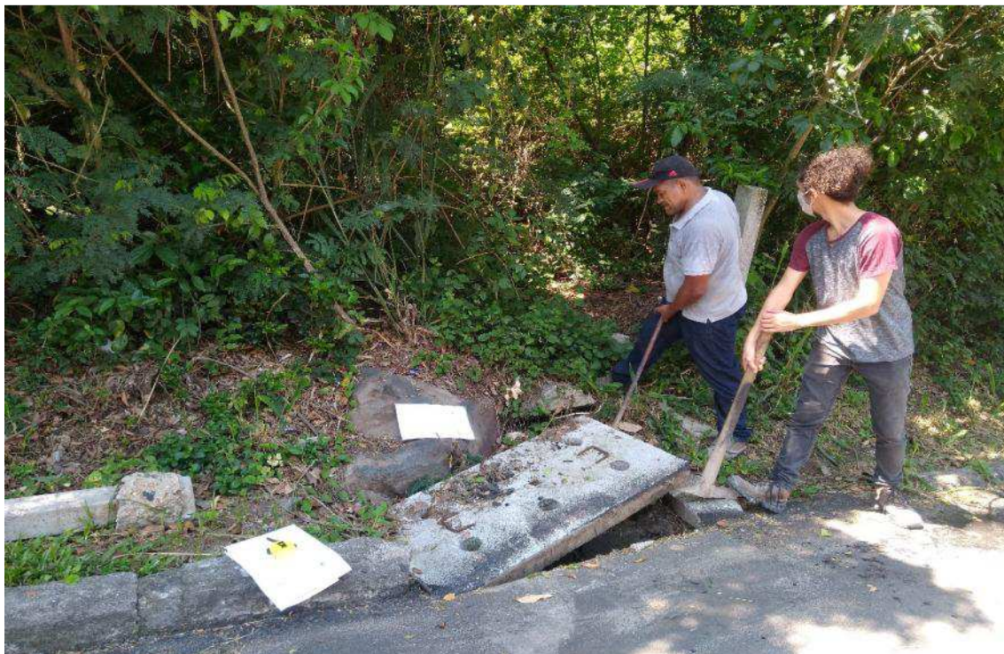
Foto 8 : PV A-06 neste ponto recebemos o escoamento das águas da Rua da Amizade
