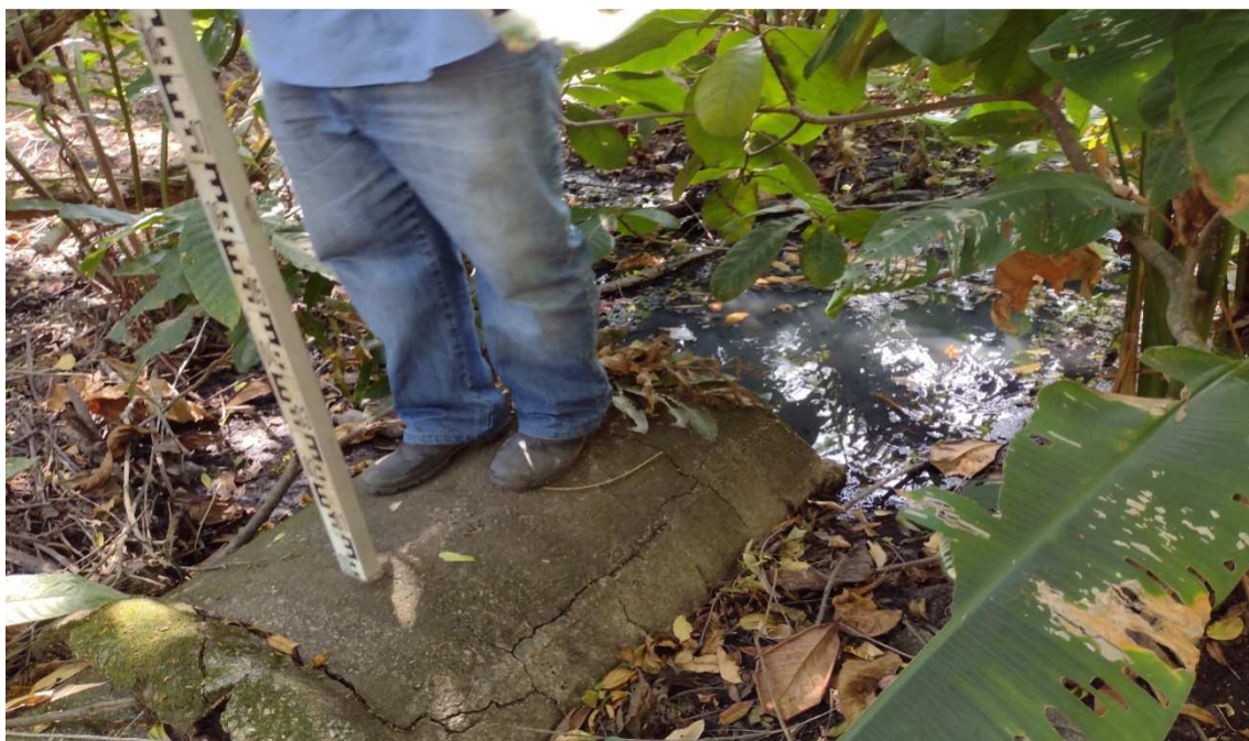
Fotos 41 : Detalhe do deságüe E com acúmulo de água na saída da manilha de 700mm
