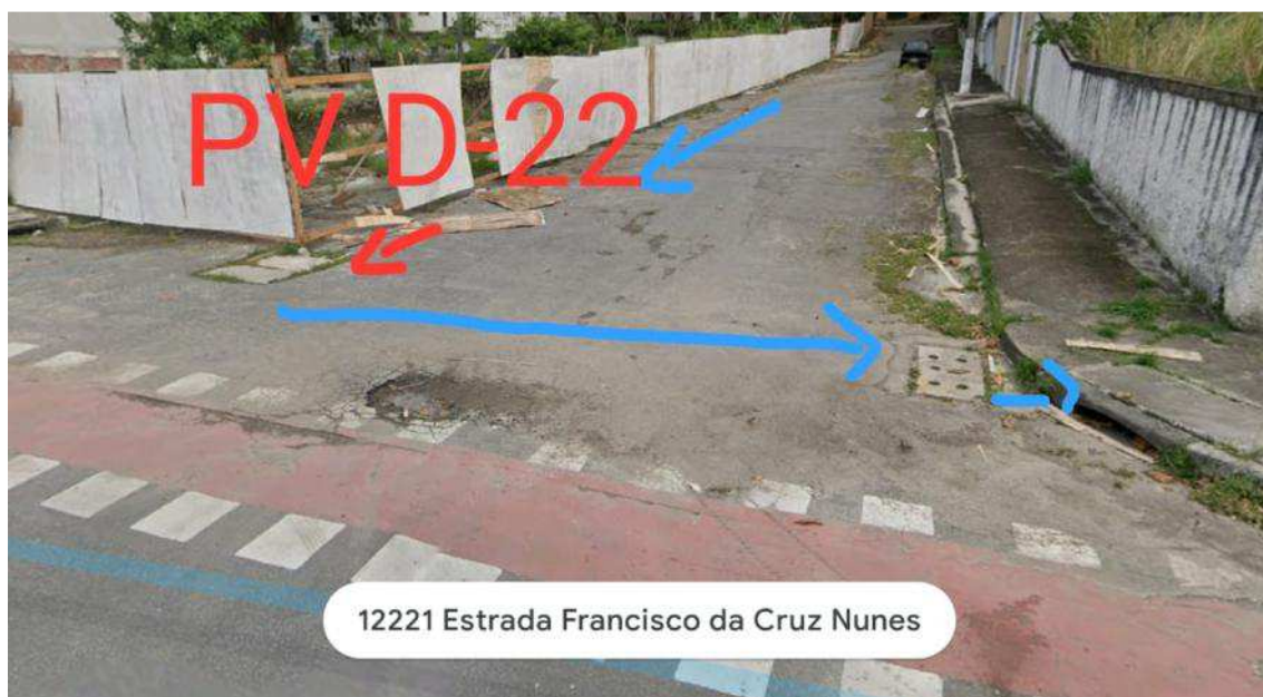
Foto 26 : Detalhe PV D-22 na esquina da Travessa Timotheo da costa que recebe a contribuição de parte das águas da Rua da Amizade a montante.
