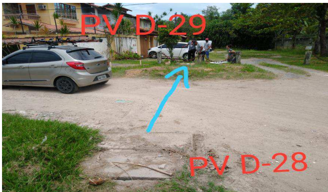
Foto 28 : Interligação dos PVs D-28 e D-29 no cruzamento das Ruas Perminio Mendonça com Póvoa de Varzim, esta interligação foi feita com uma galeria de 1,20 x 0,90m de seção.
