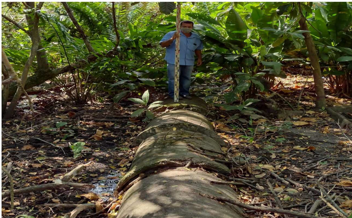
Fotos 40 : Topografia posicionada sobre a rede do deságüe E, manilha de 700mm.
