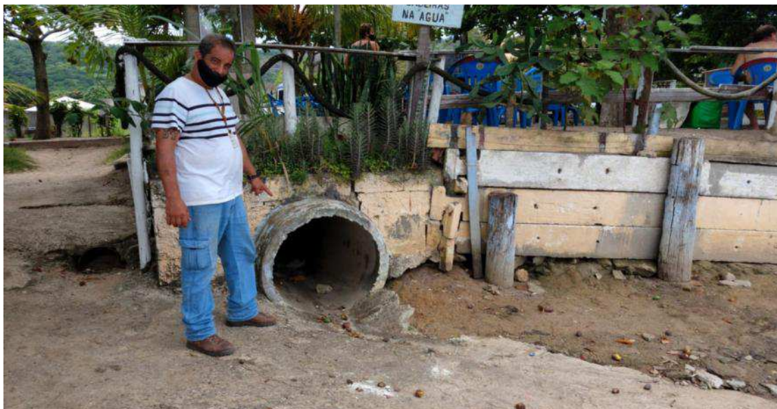
Fotos 12 : Deságüe sub-bacia B na lagoa de Itaipu com 800mm
