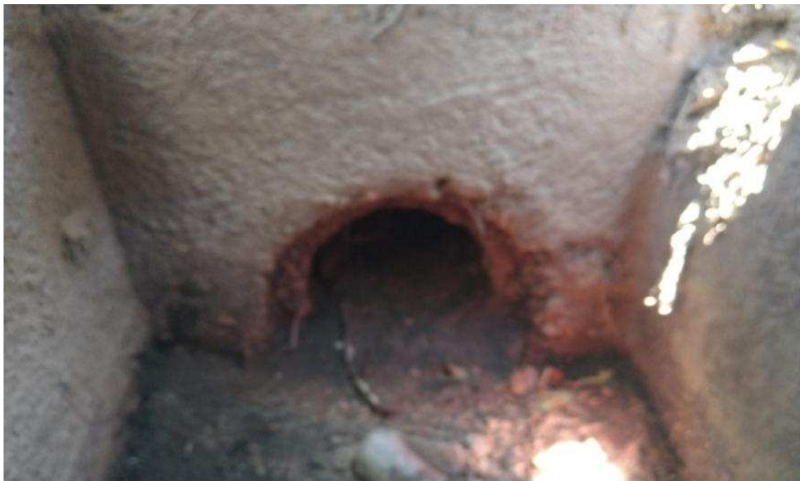
Foto 15 : Detalhe interno do PV C-01 no qual podemos ver que a rede é feita de material cerâmico com diâmetro de 300 mm.
