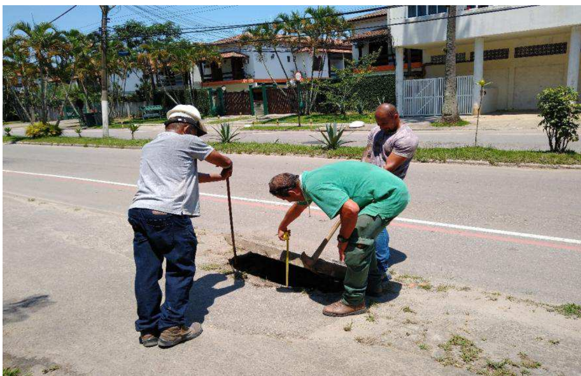
Fotos 17 / 18 : PV D-01 na Estrada Francisco da Cruz Nunes com 0,70m de profundidade
