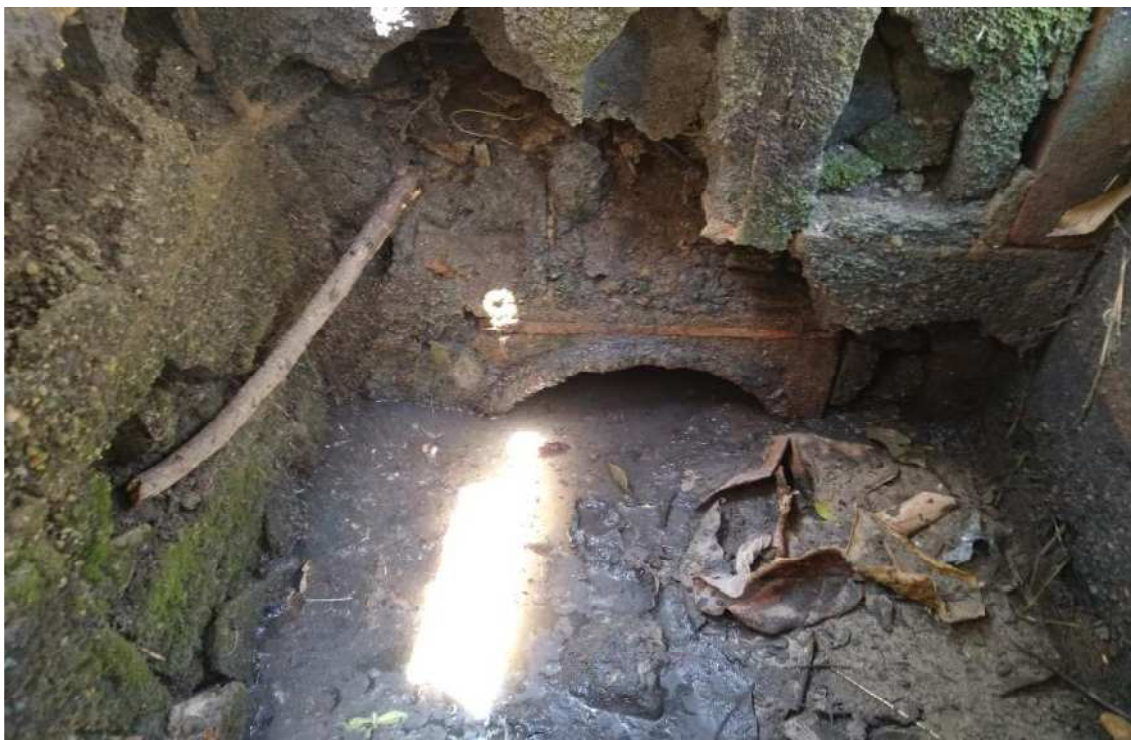
Foto 19 : Detalhe do interior do PV D-01 com sua manilha de 400mm quase que totalmente coberta por lixo e terra.
