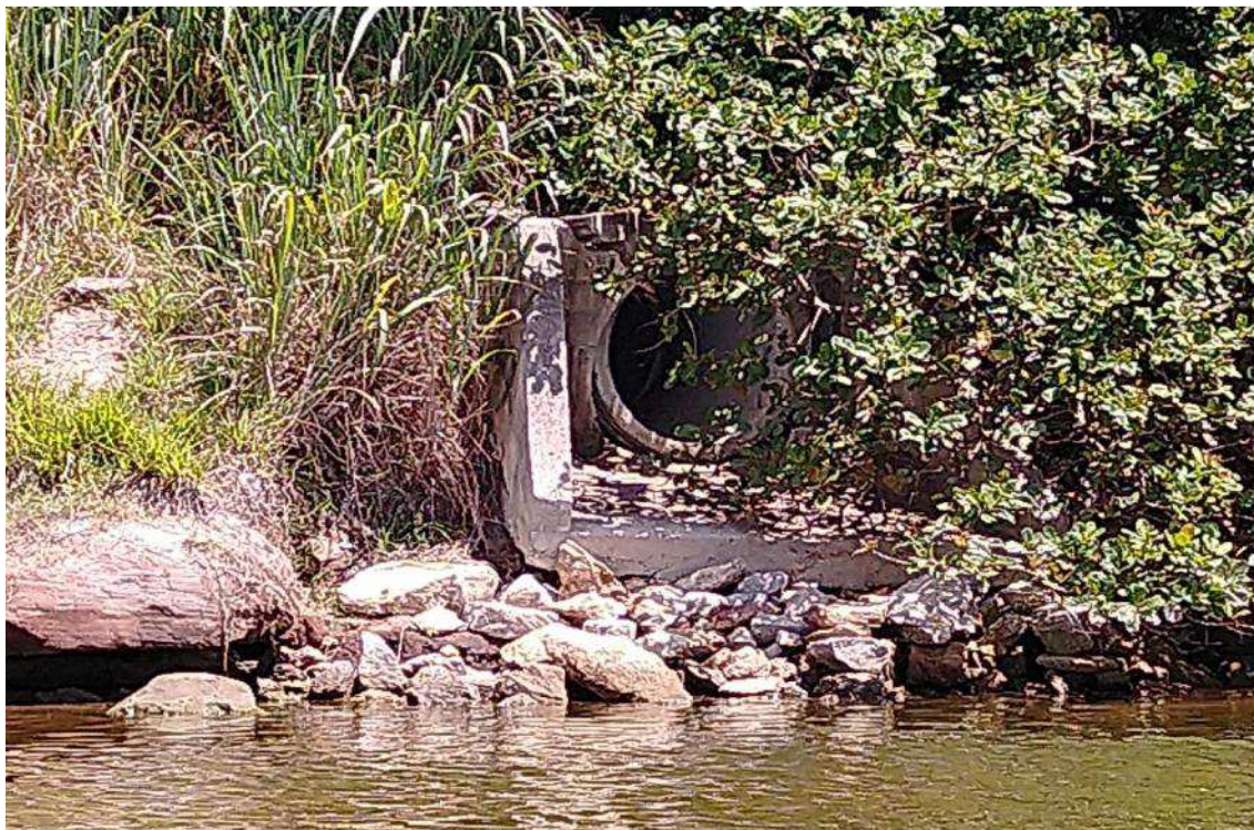
Fotos 11 : Deságüe sub-bacia A, na lagoa de Itaipu com manilha de 1200mm
