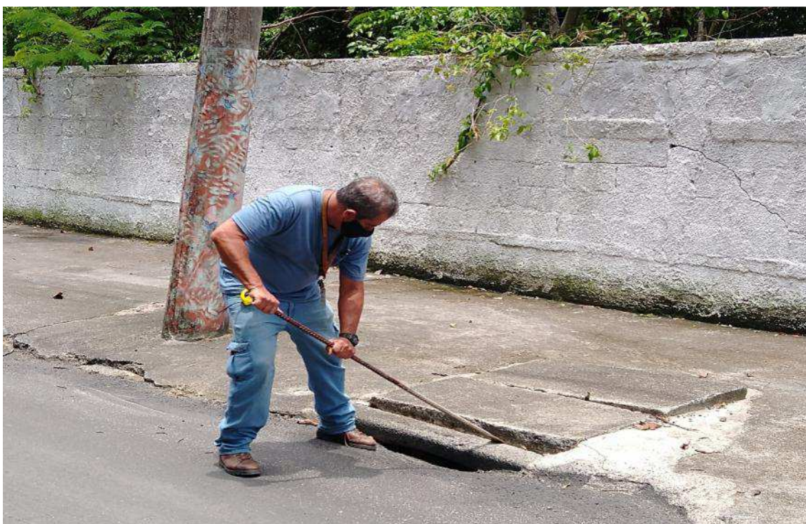
Foto 7 : PV A-05 sob a calçada da Rua São Vicente Pallotti e sistema de “boca de lobo”
