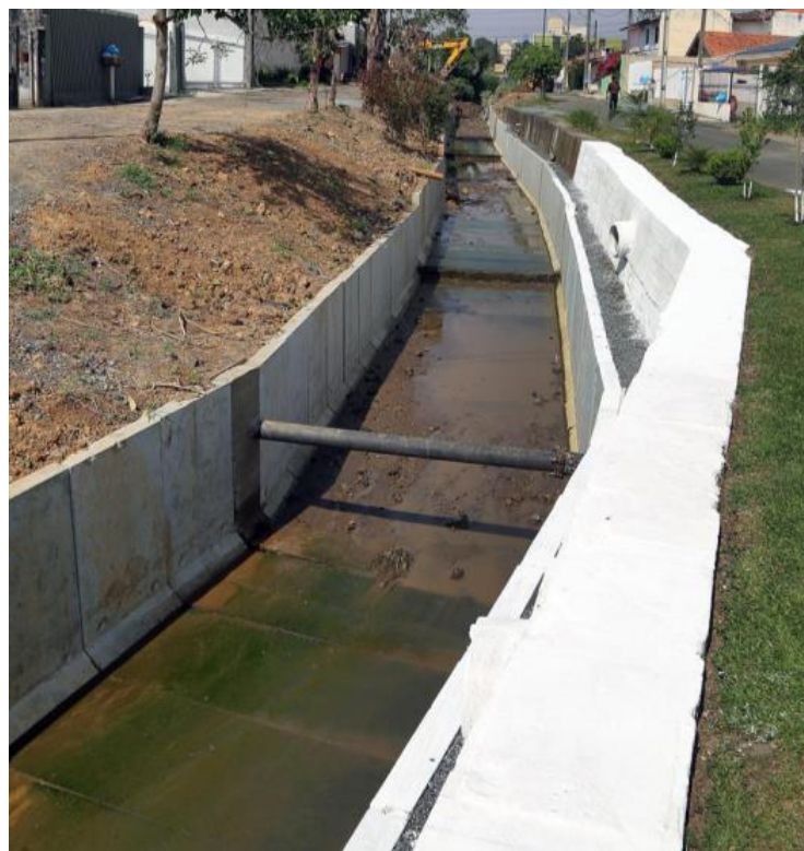
Figura 2.3.2: Cortinas de concreto.
