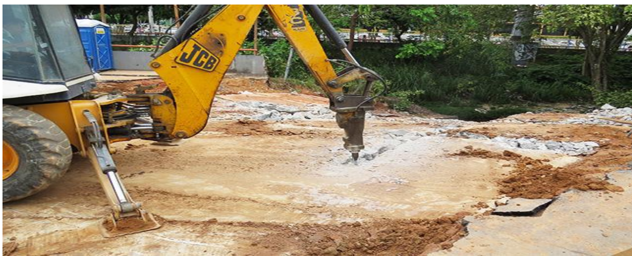
Figura 2.3: Exemplo de uso de rompedor hidráulico em demolição de pavimento.
