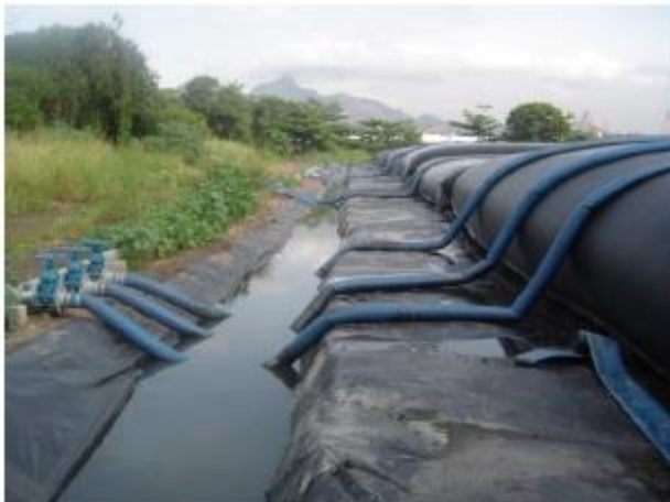
Figura 2.5.1.2: Encapsulamento do material dragado na Ilha da Pombeba durante a dragagem do Porto do Rio de Janeiro.
