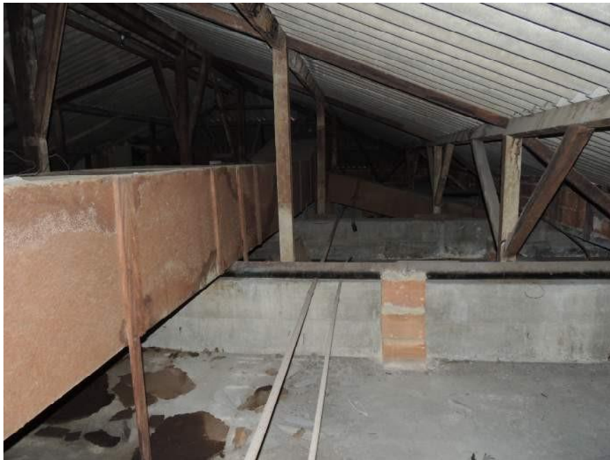
Foto 2 – Vista das vigas dos pórticos.
