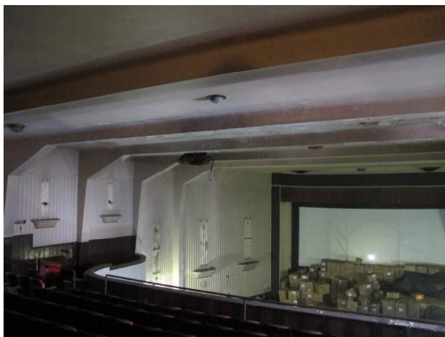
Foto 1 – Vista do balcão. Observa-se os pórticos.
