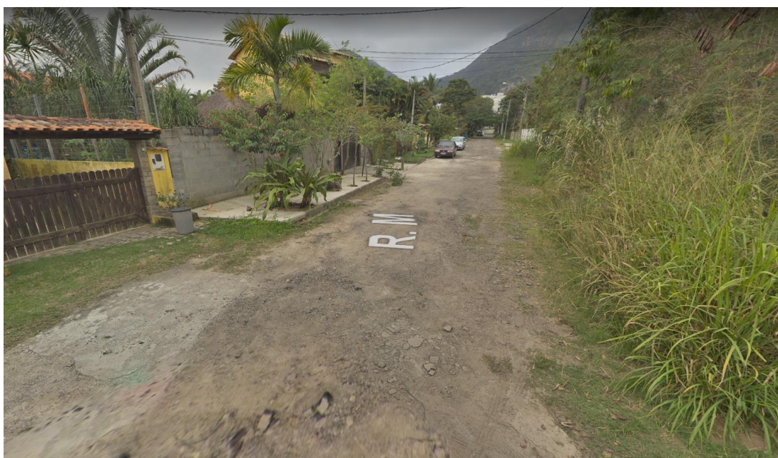
Figura 2 – Pavimentação na rua M.
