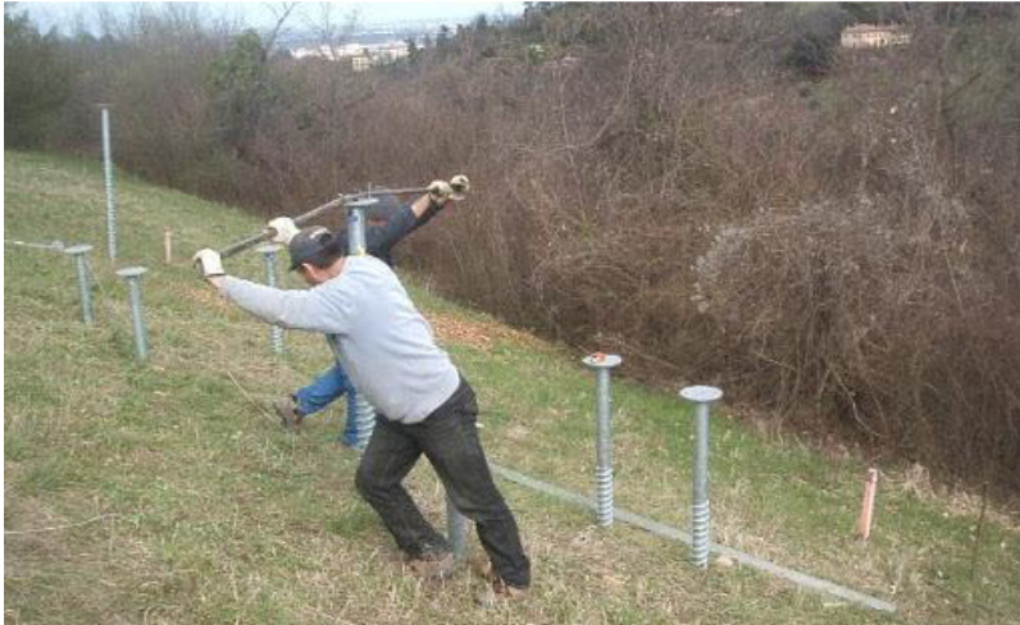
Figura A1.1 – Instalação com alavancas manuais
