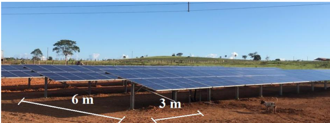
Figura 9 – Arranjo de painéis e dimensões entre suportes e fileiras
