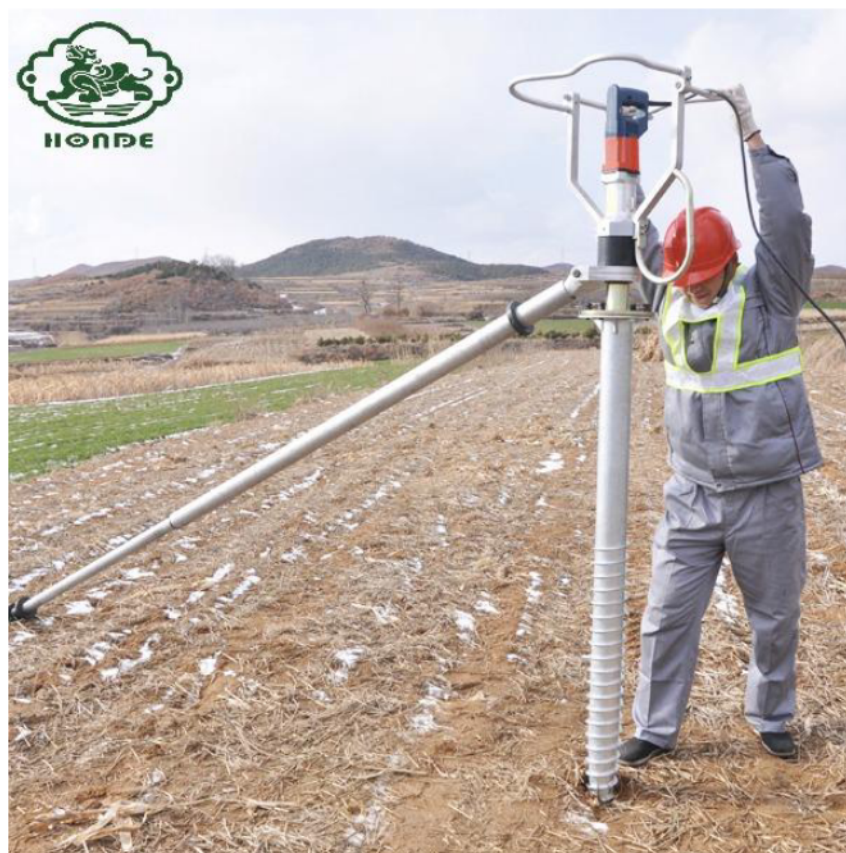
Figura A1.2 – Instalação com rotor portátil
