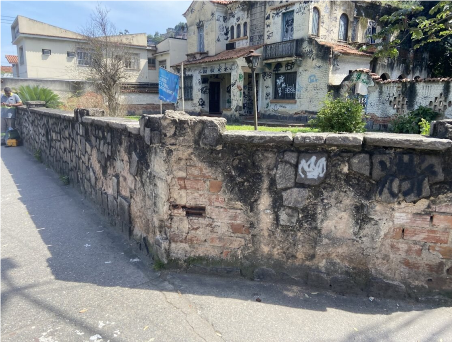
Murada com revestimento em pedra reproduzindo padrão existente no embasamento da edificação.
