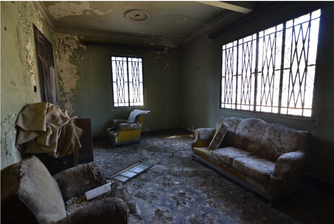
Sala de estar com esquadrias de vidro estruturadas em perfis de metal decorados com padrões geométricos.
