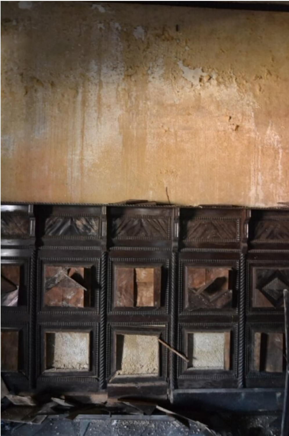
Detalhe da meia parede em painéis de madeira decorados e almofadados
