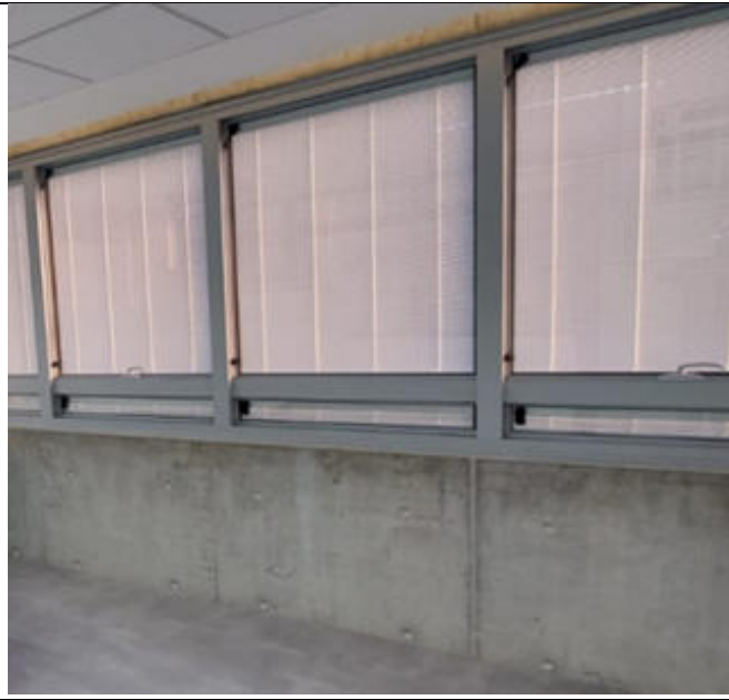
Esquadrias de Alumínio com persianas Screeline
