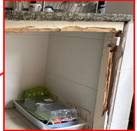
Estrutura embaixo da pia apresentando infestação de cupim.
