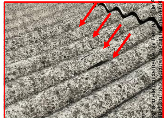
Telhado com telhas quebradas e soltas. Ausência de calhas e falta de impermeabilização.
