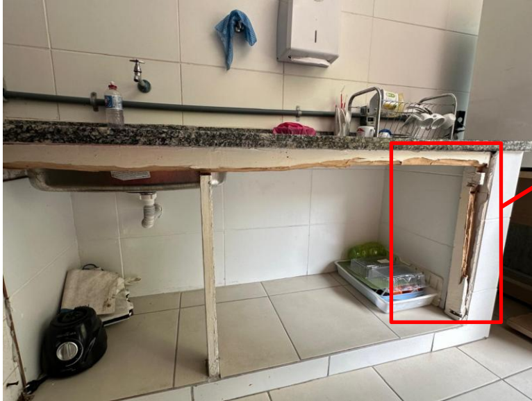
Estrutura embaixo da pia apresentando infestação de cupim.
