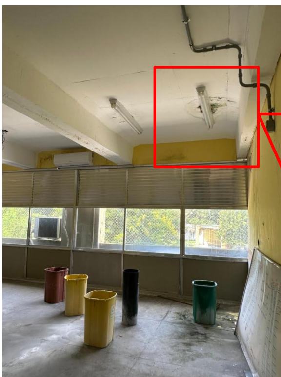
Salas de aulas apresentando infiltrações no teto.
