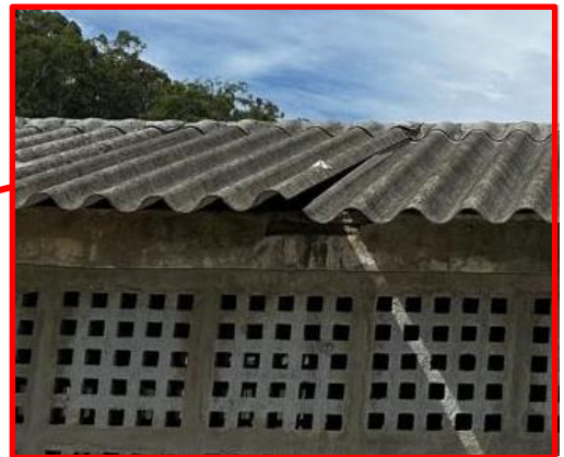
Telhado com telhas soltas e falta de calha.
