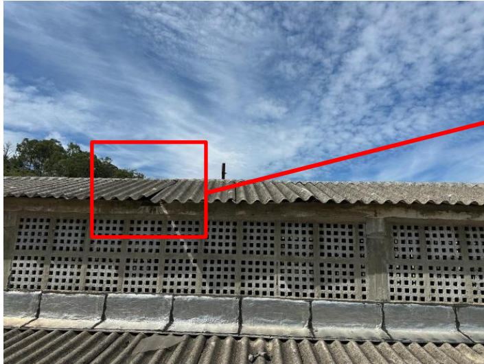
Telhado com telhas soltas e falta de calha.
