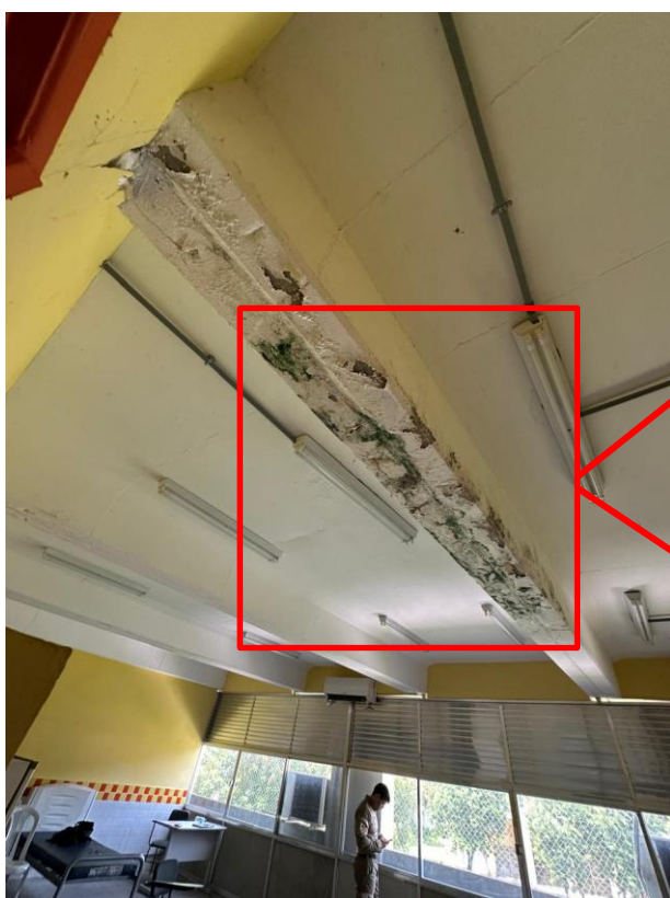
Salas de aulas apresentando infiltrações no teto.
