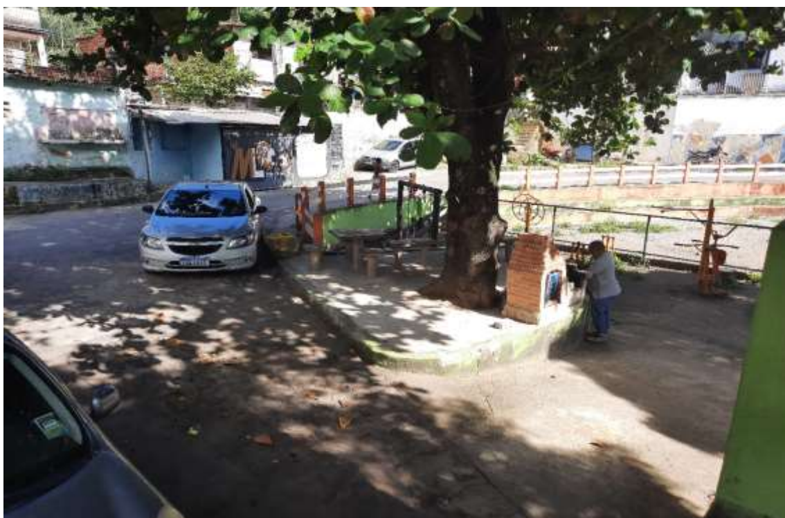
Figura 4 -Vista Área onde ficam os bancos de concreto e churrasqueira já existentes.
