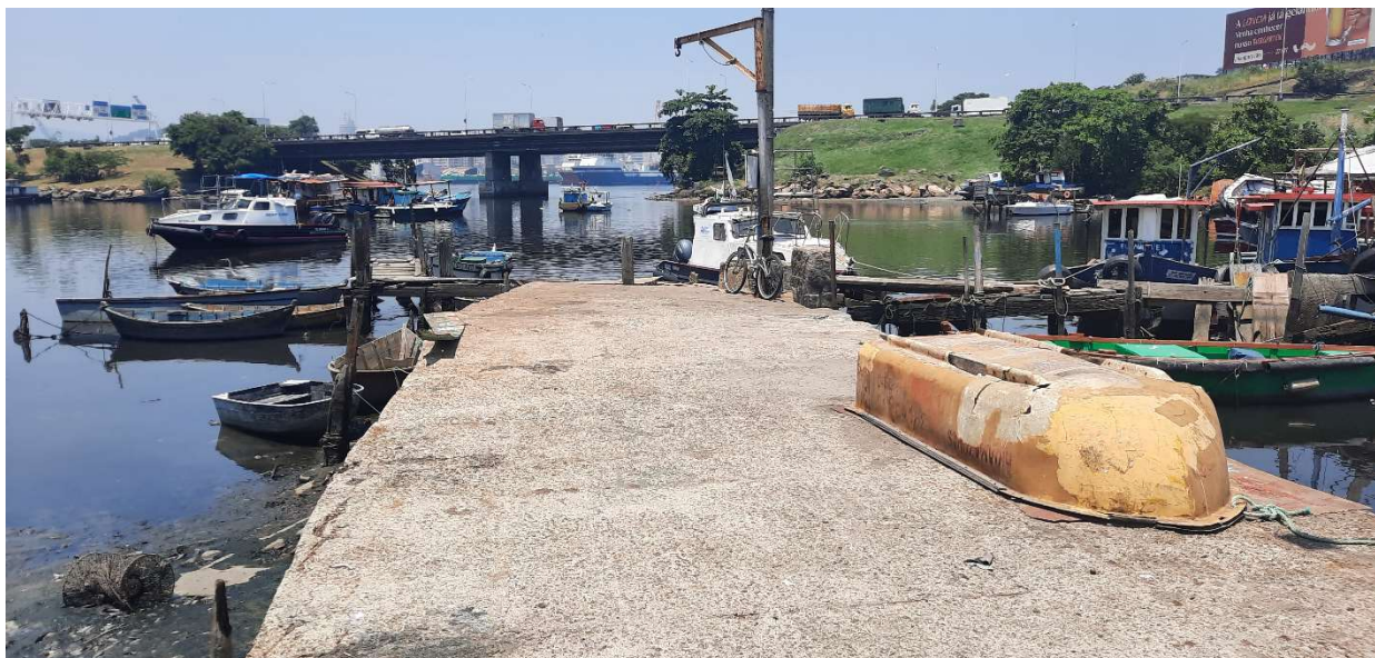
5.1.2 – Figura 02: Foto do local de intervenção.
