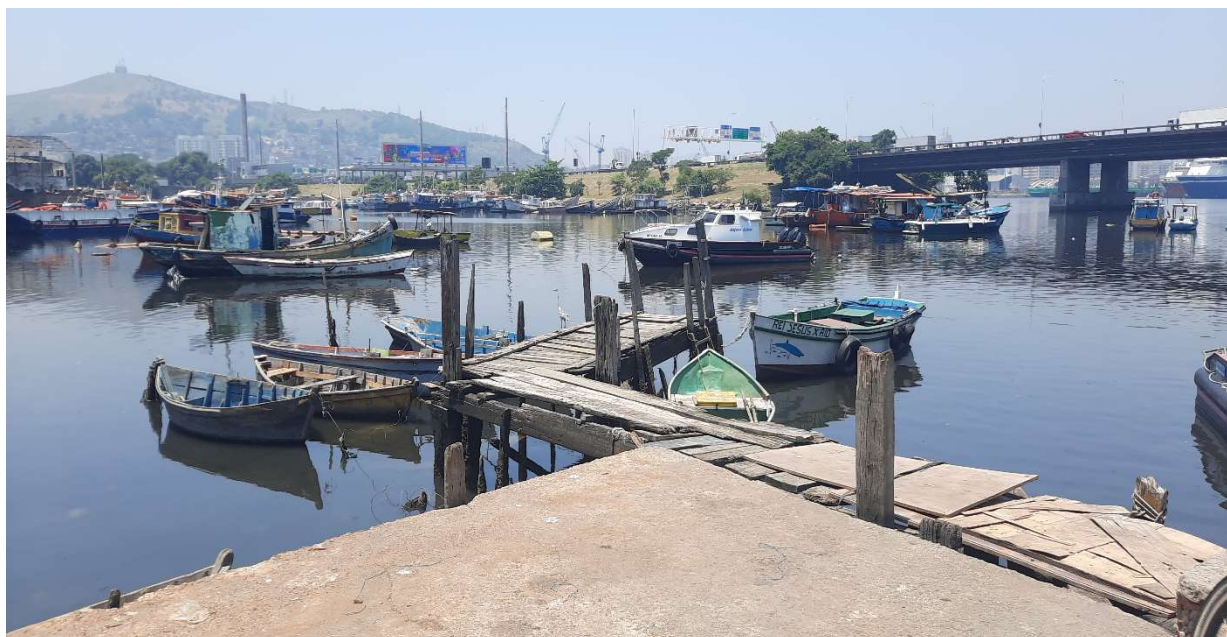
5.1.3 – Figura 03: Foto do local de intervenção.
