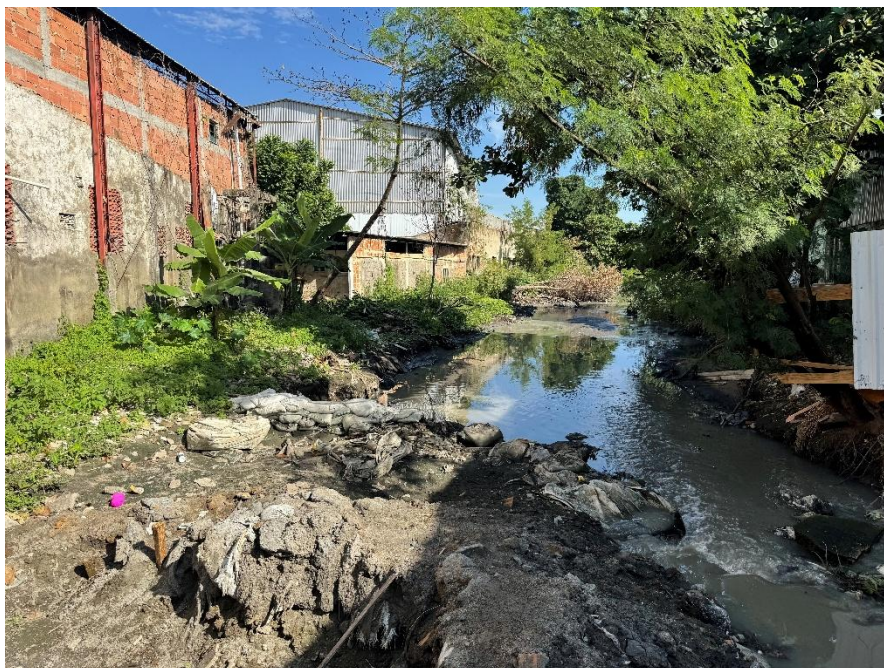
5.1.1 – Figura 01: Localização da Intervenção – Trecho a jusante.
