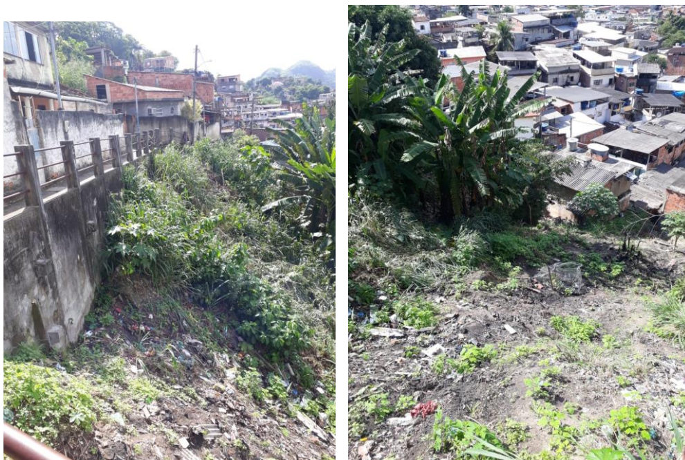
Figura 05 e 06: Foto do local de intervenção Ponto 03.
