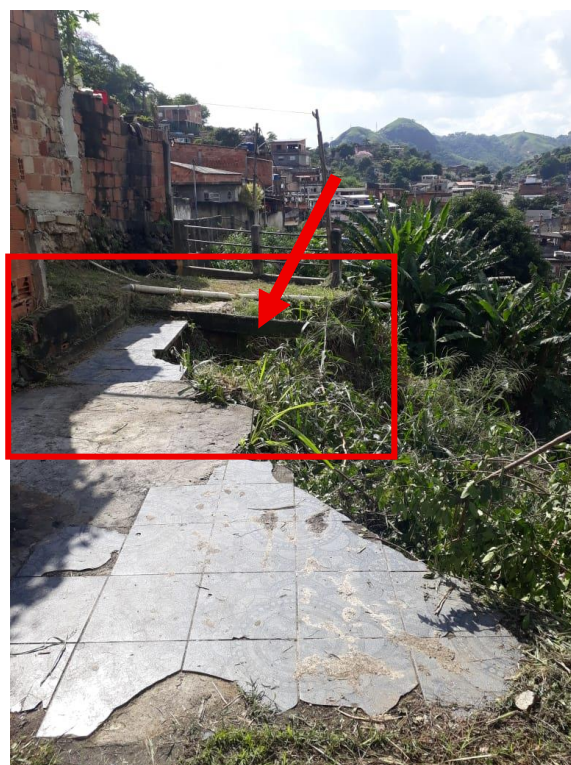
Figuras 9 e 10 – Ponto 03: Trecho de acesso com colapso parcial causado por escorregamento de solo
