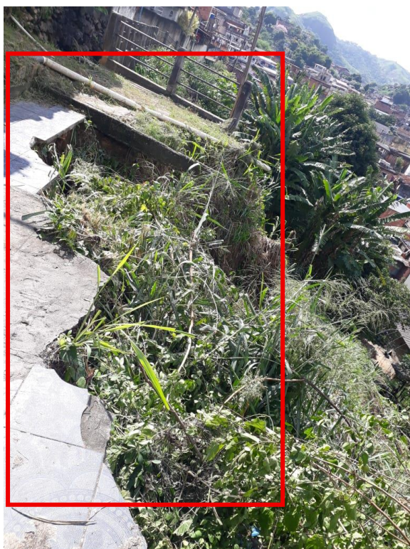
Figuras 9 e 10 – Ponto 03: Trecho de acesso com colapso parcial causado por escorregamento de solo
