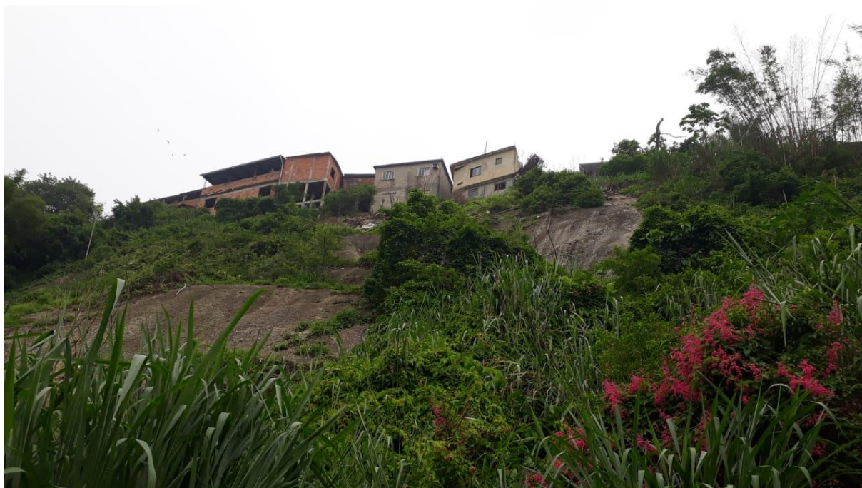
Figura 08 – Ponto 02: Vista da encosta
