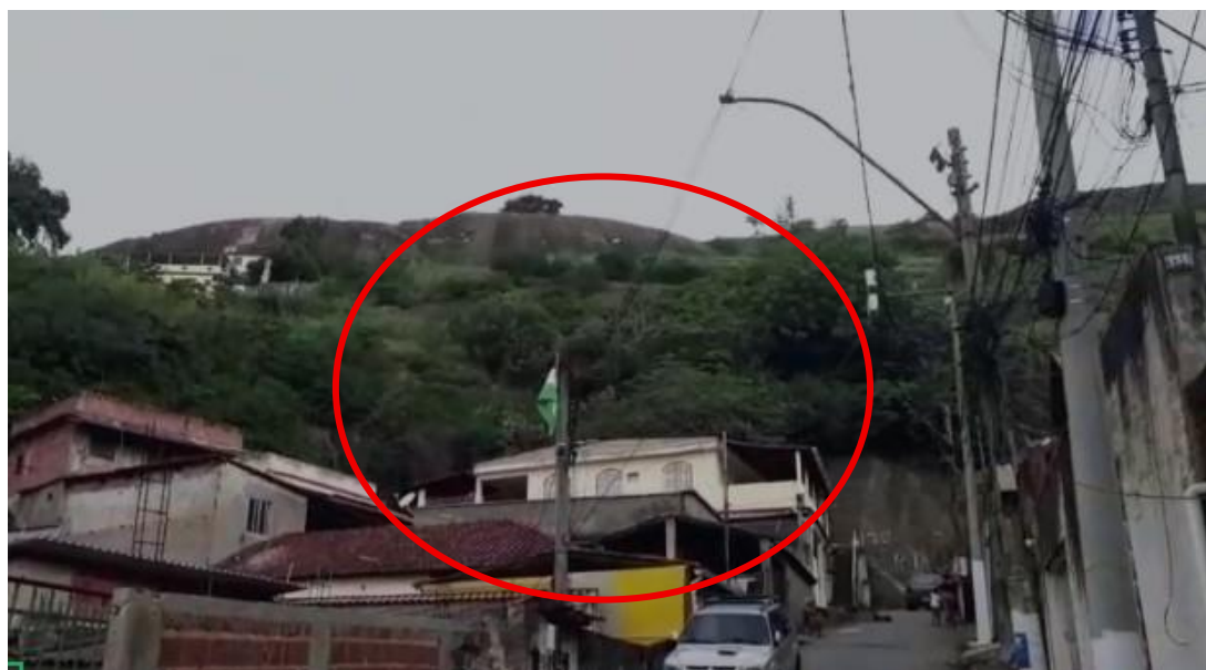
Figura 1 – Vista da encosta
