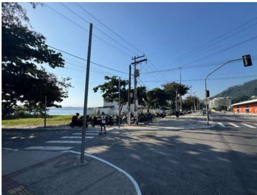
Figura 1 – Entrada da área do estacionamento que sofrerá a intervenção para a obra do Bicicletário
