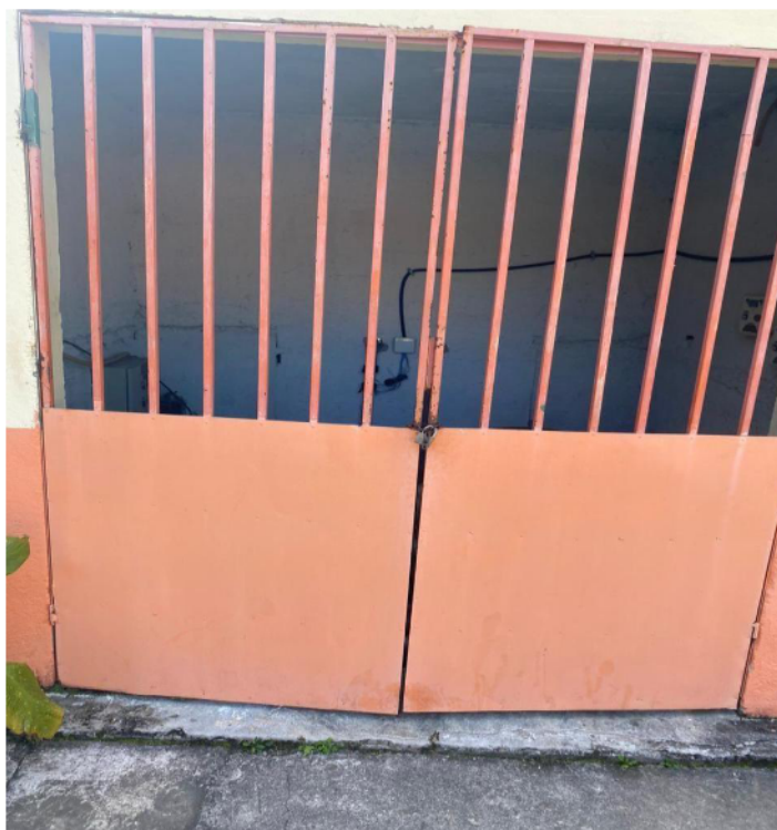
Figura 3 – Casa de força
