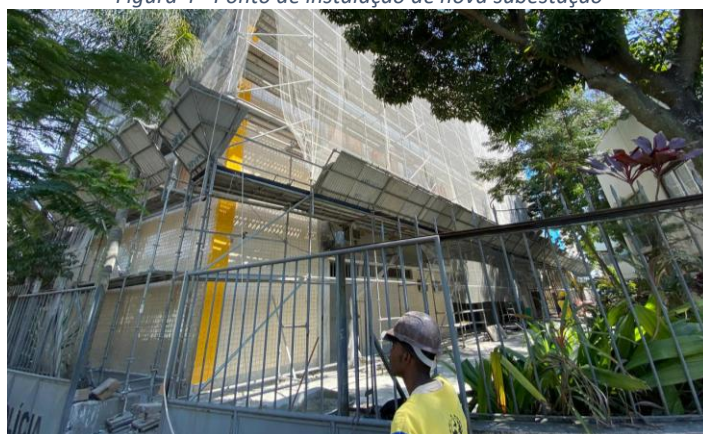
Figura 5 - Prédio onde será instalado ar condicionado e elevadores
