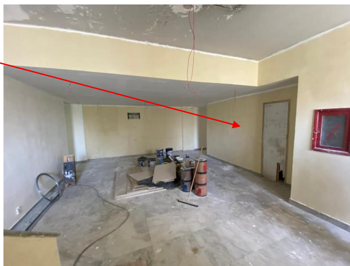
Figura 8 - Hall de elevadores (5 paradas)
