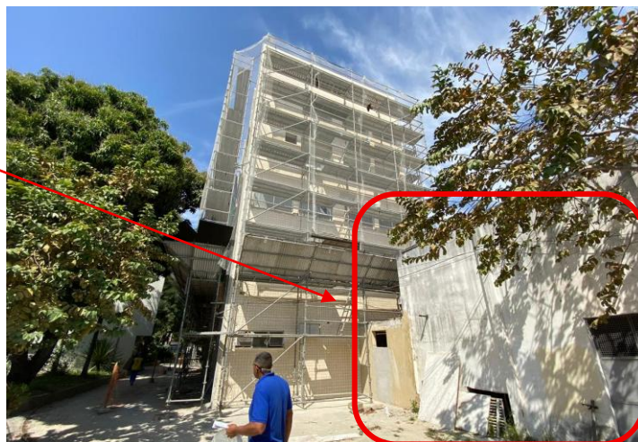
Figura 4 - Ponto de instalação de nova subestação
