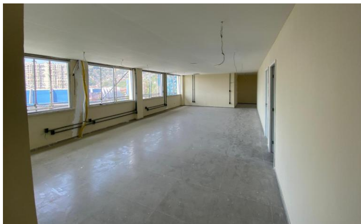
Figura 12 - Salas para a instalação do ar-condicionado.
