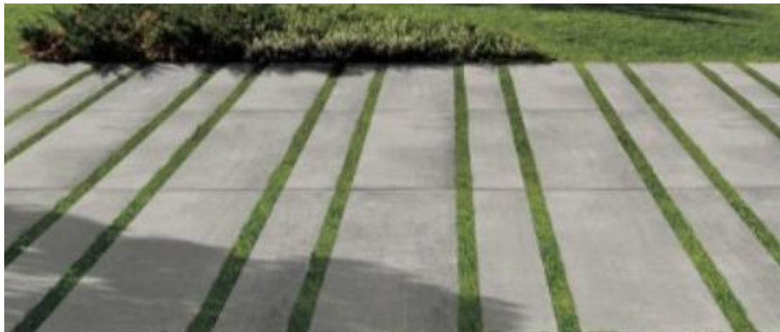
PISO EM CONCRETO ENTREMEADO COM GRAMA
