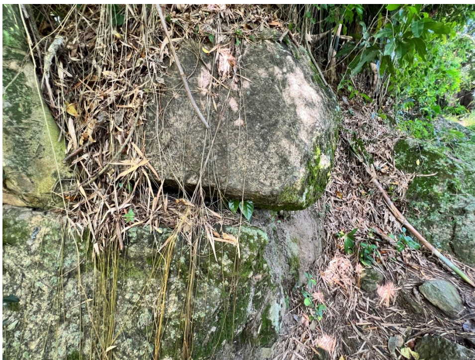
5.1.5 – Figura 5: Foto do local de intervenção.
