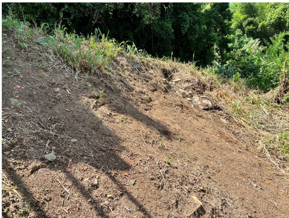
5.1.2 – Figura 02: Foto do local de intervenção.
