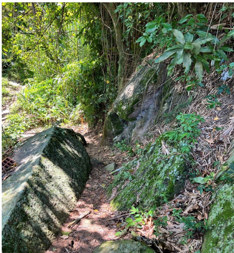
5.1.4 – Figura 4: Foto do local de intervenção.
