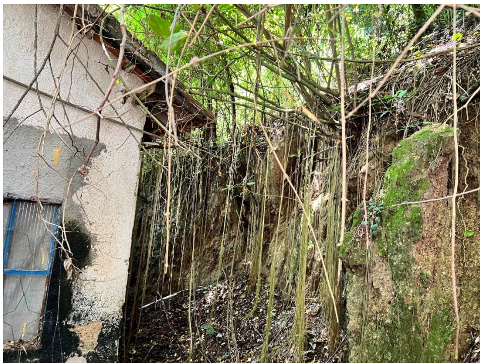
5.1.3 – Figura 03: Foto do local de intervenção.
