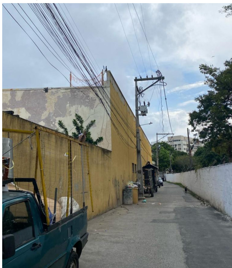
Figura 3 - Local que será instalado um Ramal
