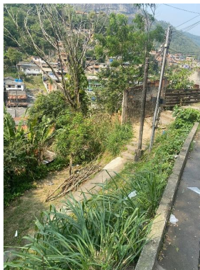
Figura 1 – Trecho de encosta em área urbana apresentando talude exposto e ausência de obras de contenção, com risco potencial de instabilidade e processos erosivos, evidenciando a necessidade de implantação de sistema de contenção e drenagem para garantia da segurança viária e das áreas adjacentes.
