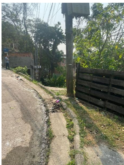
Figura 1 – Trecho de encosta em área urbana apresentando talude exposto e ausência de obras de contenção, com risco potencial de instabilidade e processos erosivos, evidenciando a necessidade de implantação de sistema de contenção e drenagem para garantia da segurança viária e das áreas adjacentes.
