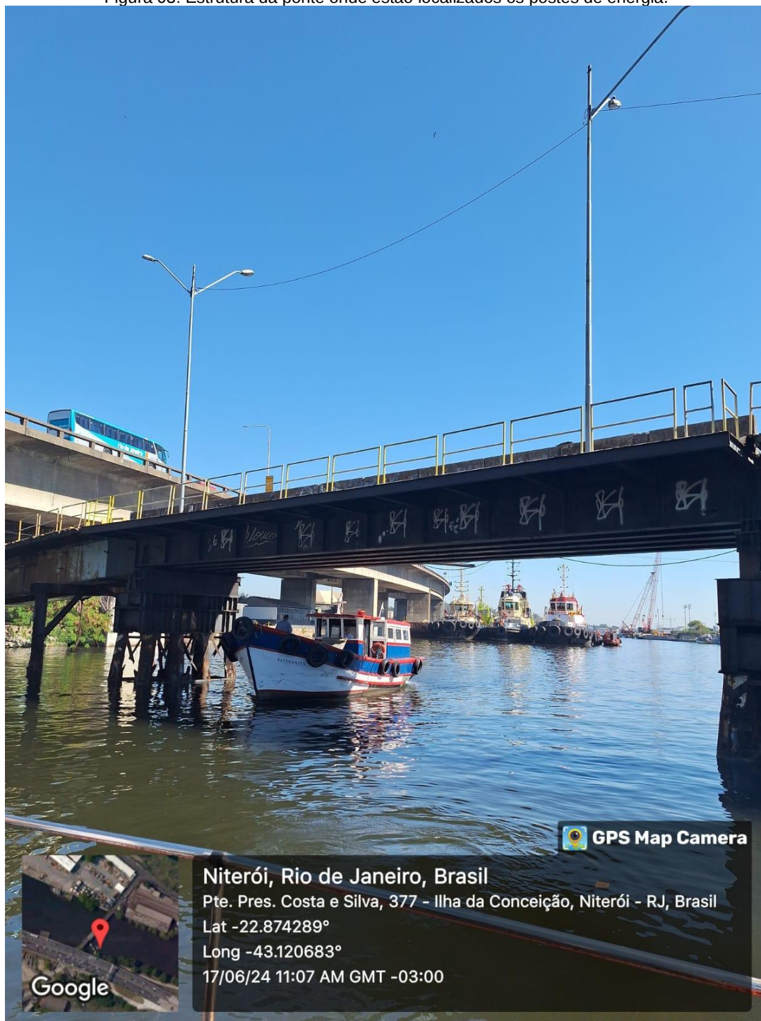
Figura 03: Estrutura da ponte onde estão localizados os postes de energia.
