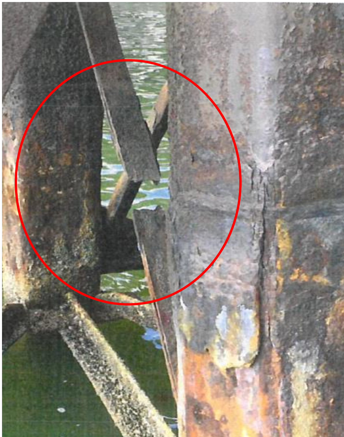
Figura 06 :Pilares de aço em estágio avançado de corrosão/ ruptura das treliças de amarração.
