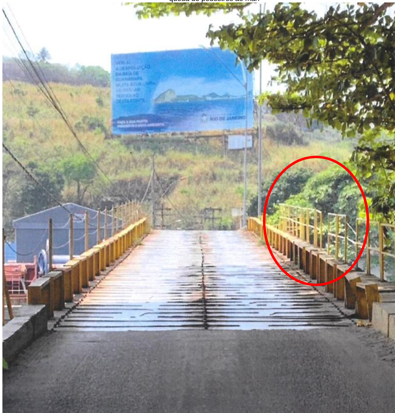
Figura 8 – Trecho de Acesso com Guarda-corpos quebrados necessitando de imediata reconstrução - risco de queda de pedestres ao mar.
