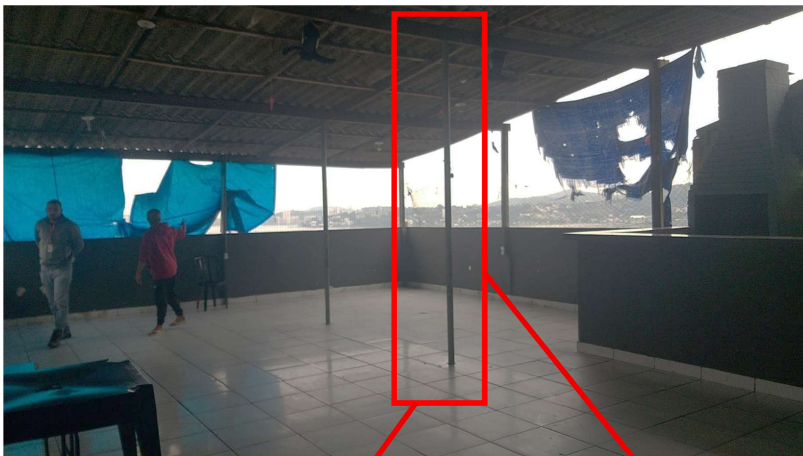
Figura 6 - Estrutura da laje na área do telhado
