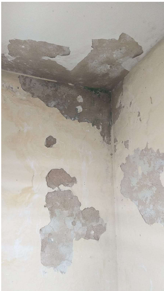
Figura 7- Espaço com marcas de infiltração
