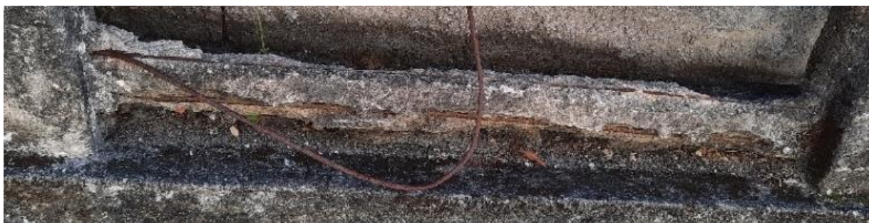
Figura 6 – Detalhe do guarda-corpo
