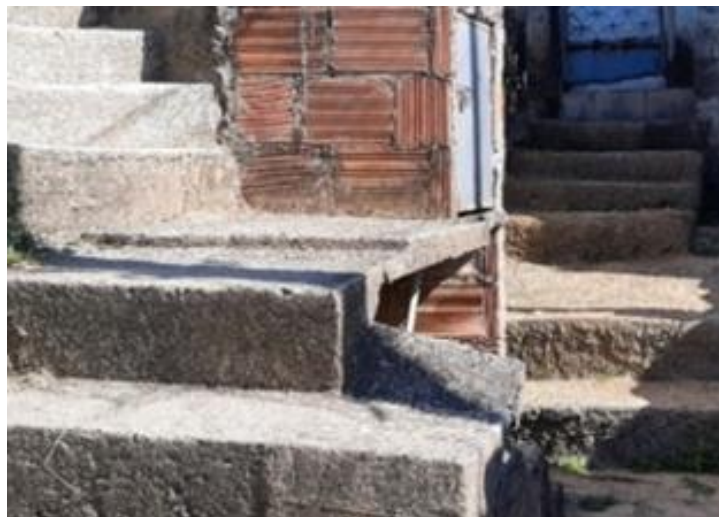
Figura 2 – Detalhe do acesso
