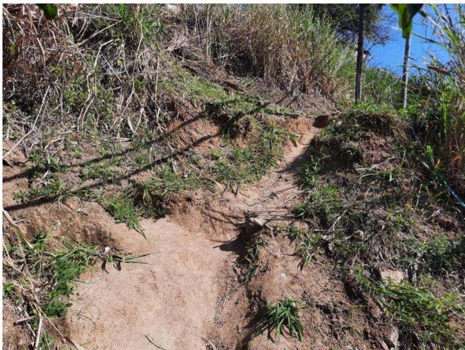
Figura 14 – Trecho de descida à Travessa da Fonte, ausência de escada ou pavimentação mínima
