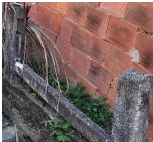
Figura 4 – Detalhe do guarda-corpo
