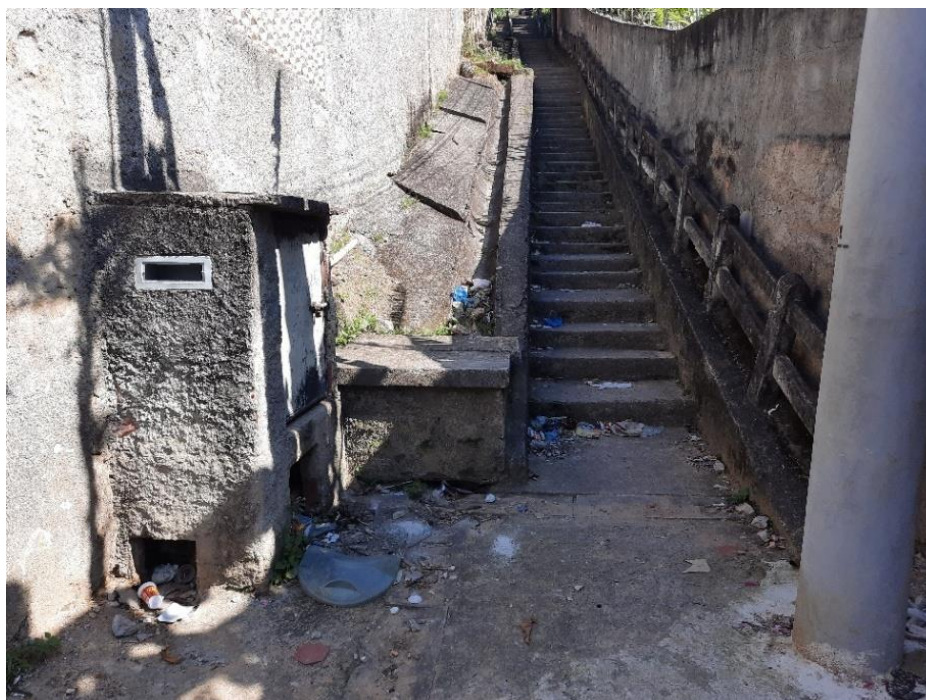
Figura 7 – Acesso a escadaria
