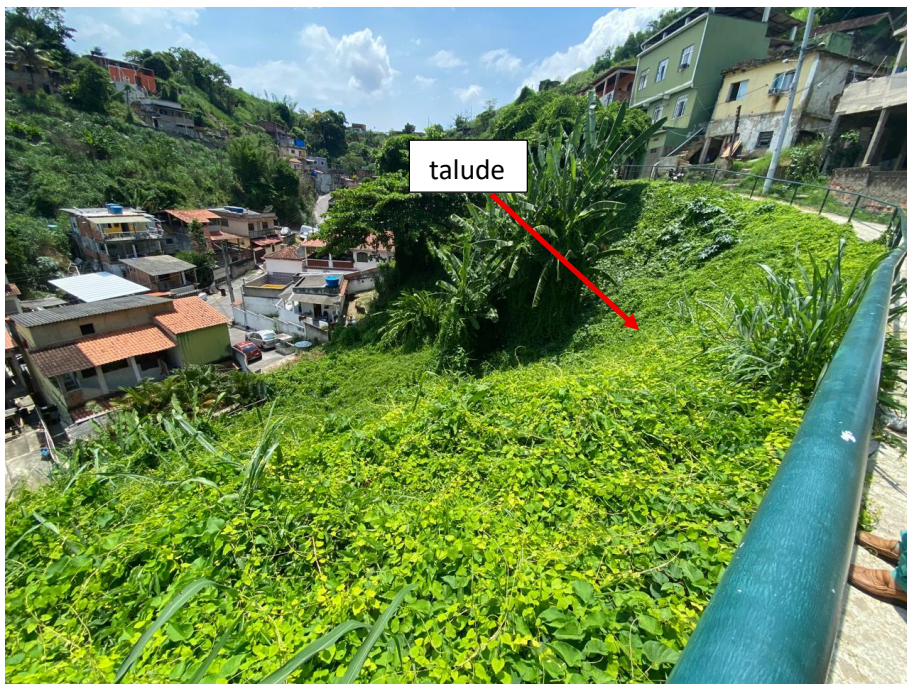
Figura 2 – Vista do local.
