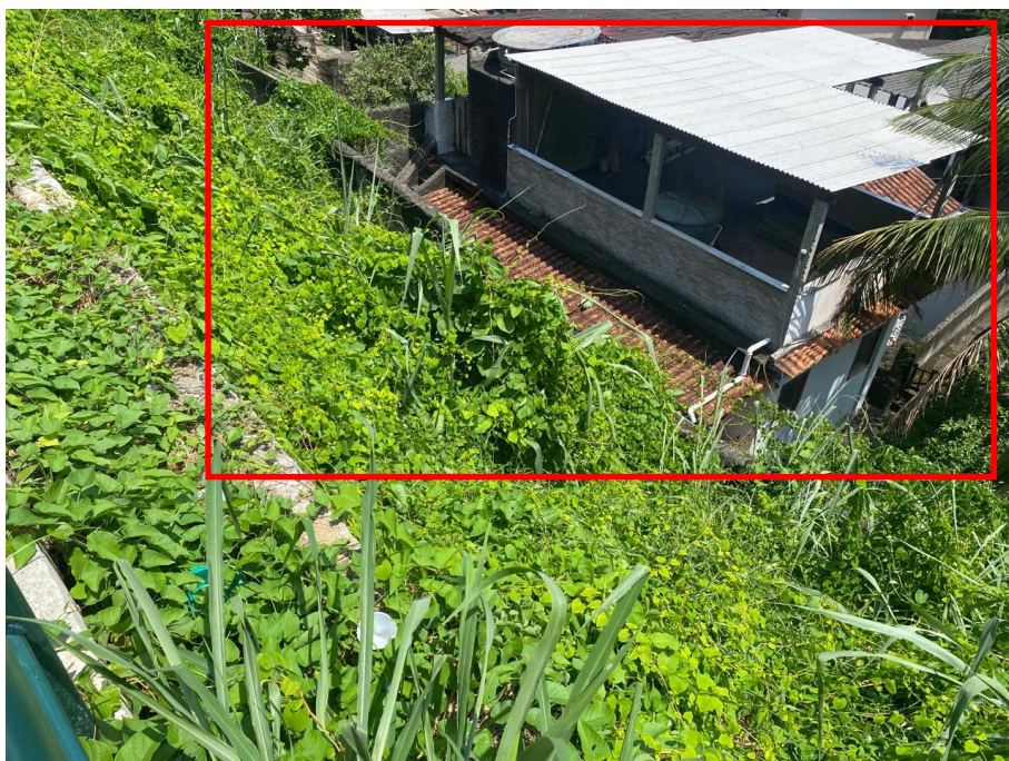
Figura 3 – Vista do local, imóveis a jusante do talude.
