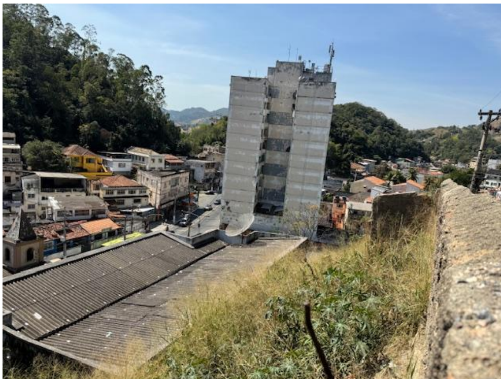
Figuras 7 – Vista por um trecho do muro.
