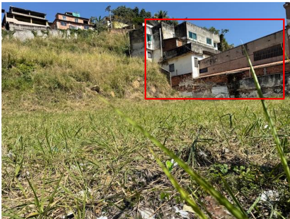
Figuras 4 – Edificações próximas ao talude.
