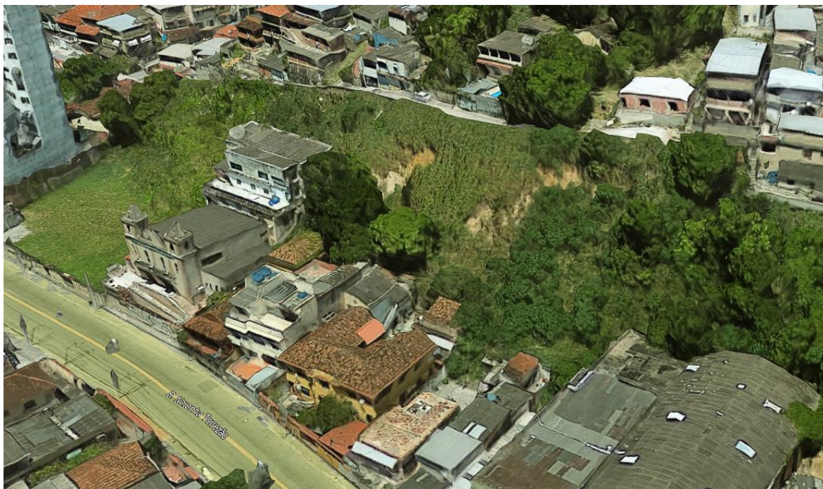
Figura 02: Foto do local de intervenção.
