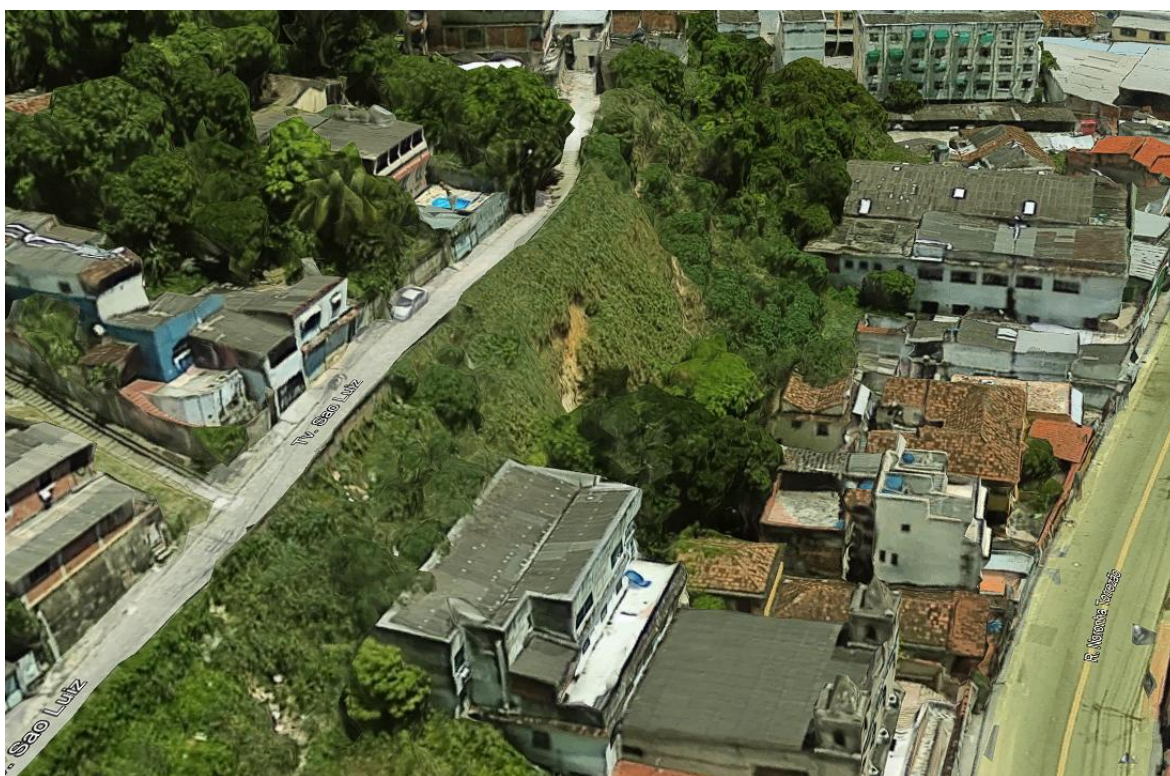
Figura 03: Foto do local de intervenção.
