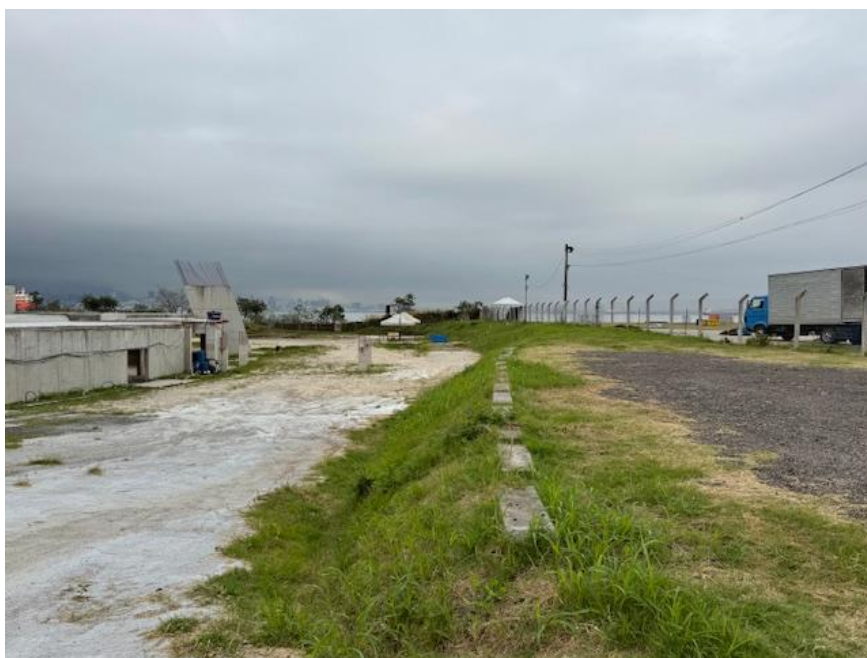
Figura 1 – Vista do local.
