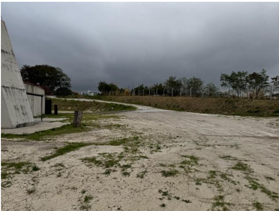
Figura 7 – Vista do local.
