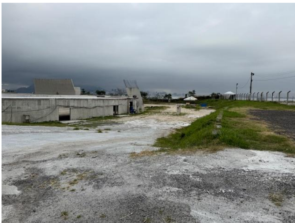
Figura 3 - Vista de trecho que dá acesso ao local.
