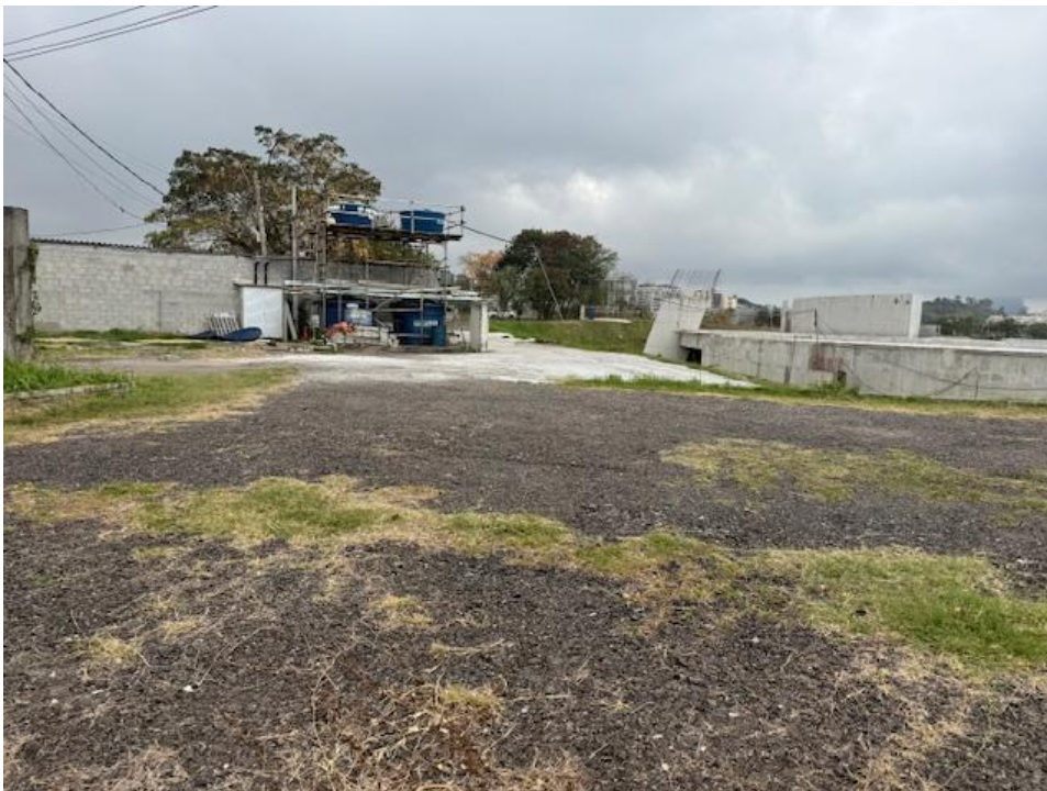
Figura 4 – Vista do local.
