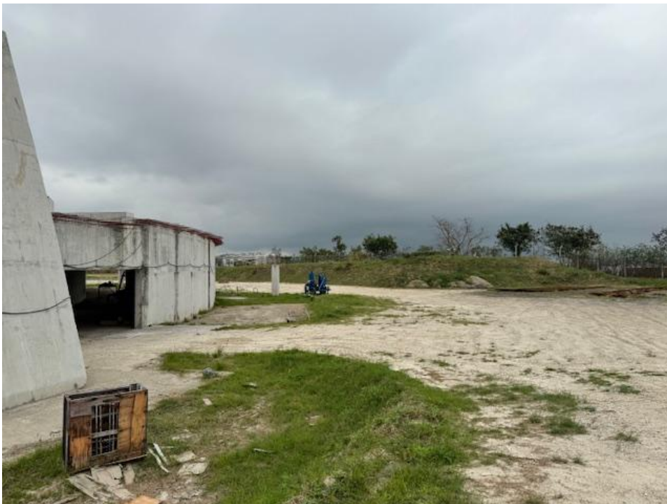
Figura 6 – Vista do local.
