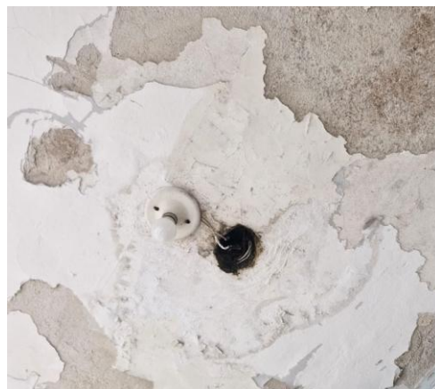
Figura 20 - Detalhe do teto da sacada
