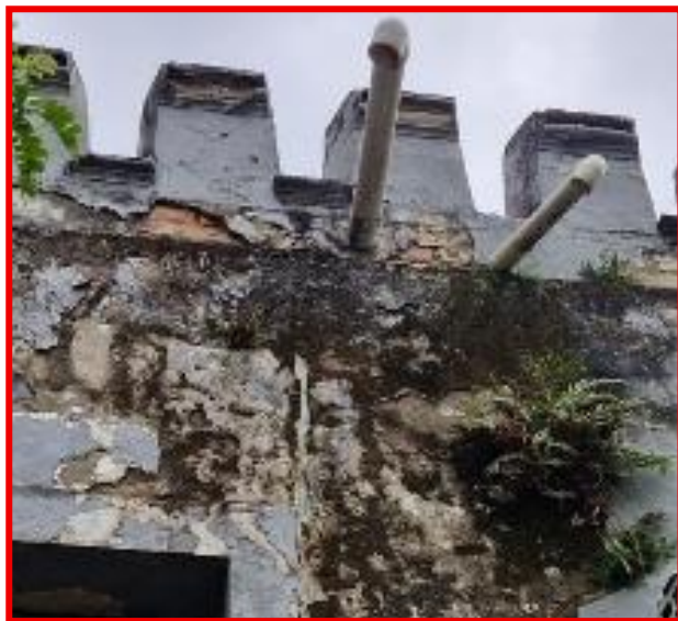
Figura 27 – Detalhe da fachada externa
