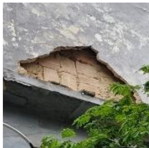
Figura 32 - Detalhe da fachada externa
