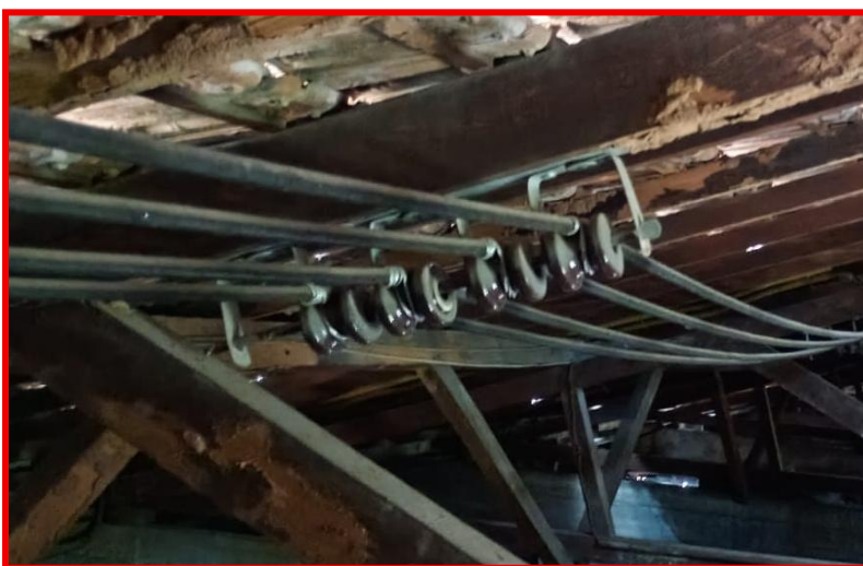
Figura 34 – Detalhe do interior do telhado
