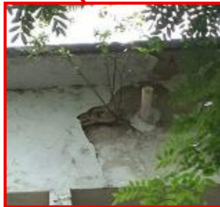
Figura 6 - Detalhe da fachada superior
