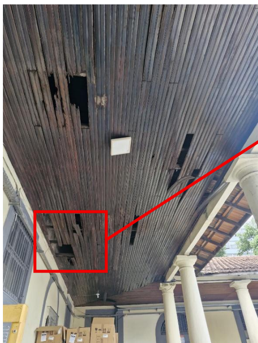
Figura 12 - Forro de madeira
