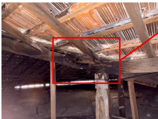
Figura 39 - Interior do telhado
