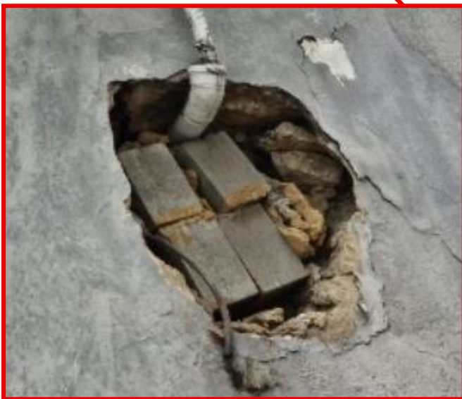
Figura 26 – Detalhe da fachada externa
