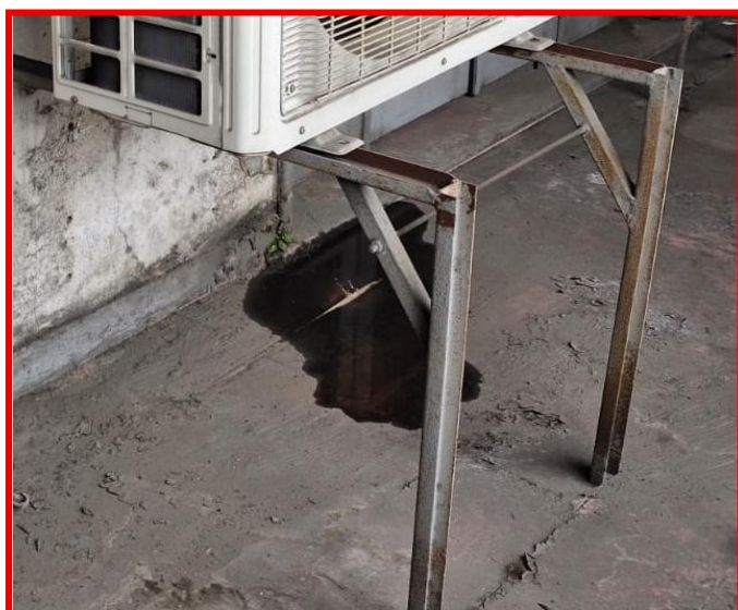
Figura 17 – Detalhe de apoio do ar condicionado
