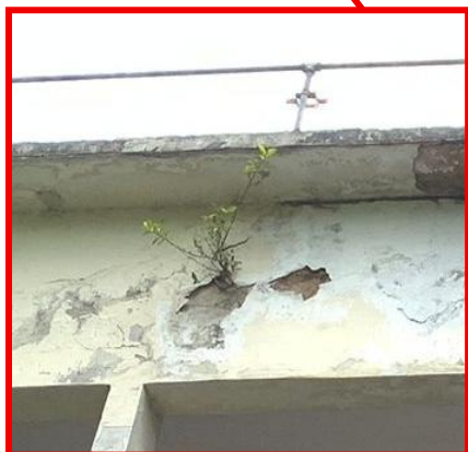
Figura 5- Detalhe da fachada superior
