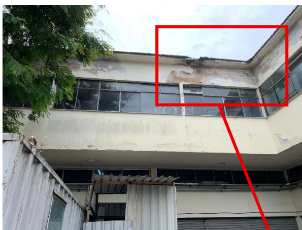
Figura 2 - Fachada superior interna
