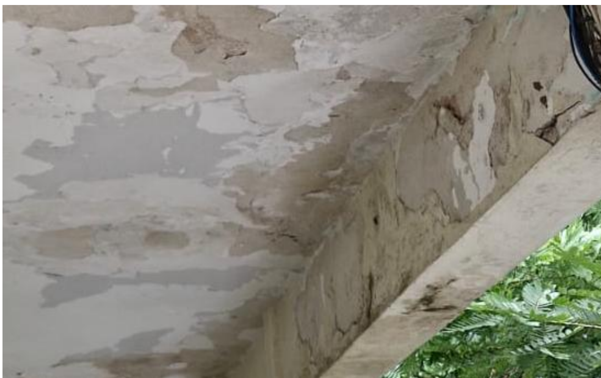
Figura 21 – Detalhe do teto da sacada
