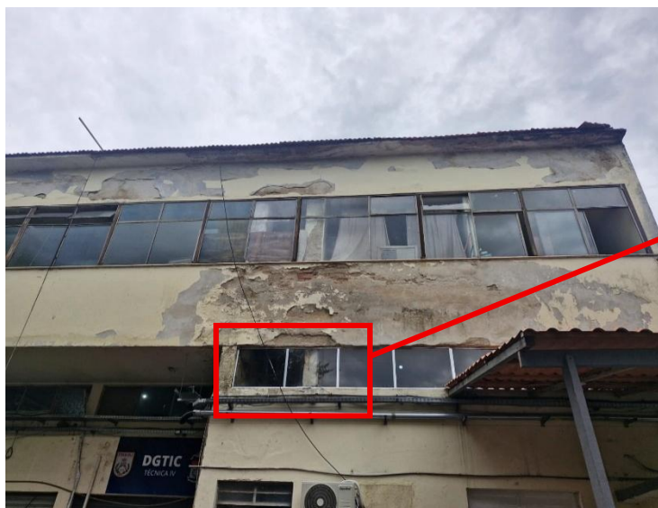
Figura 14 - Fachada superior interna
