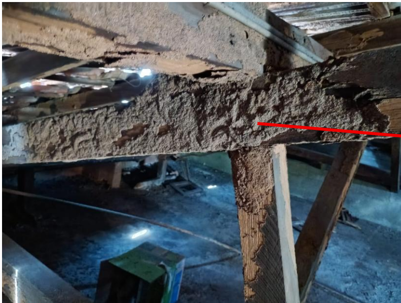
Figura 33 – Interior do telhado
