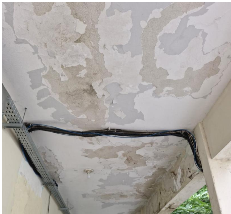
Figura 19 - Teto da sacada
