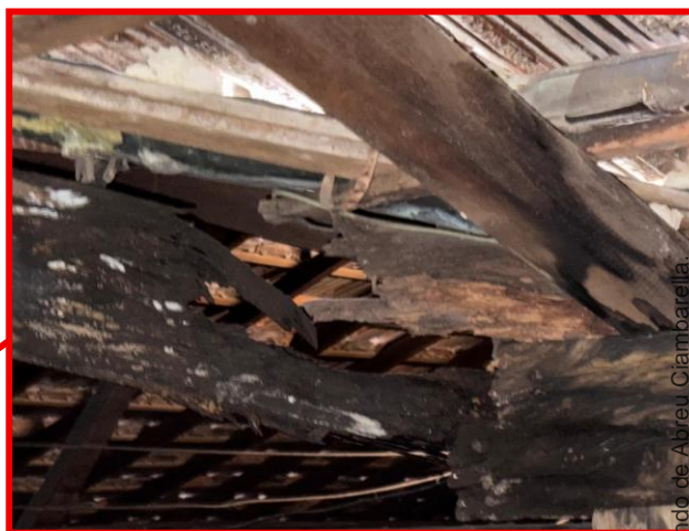
Figura 40 – Detalhe do telhado
