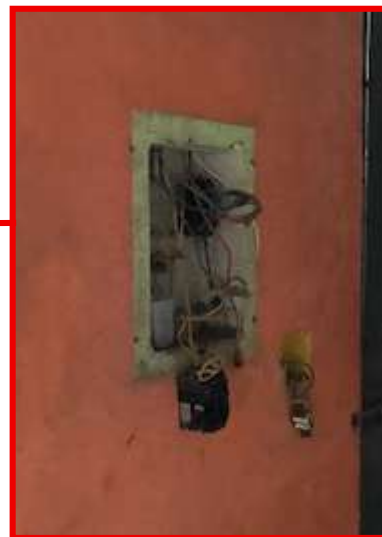
Figura 6 - Detalhe da área interna
