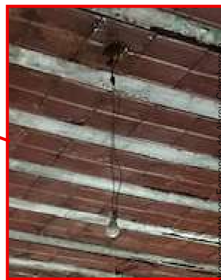
Figura 8 - Detalhe da área interna
