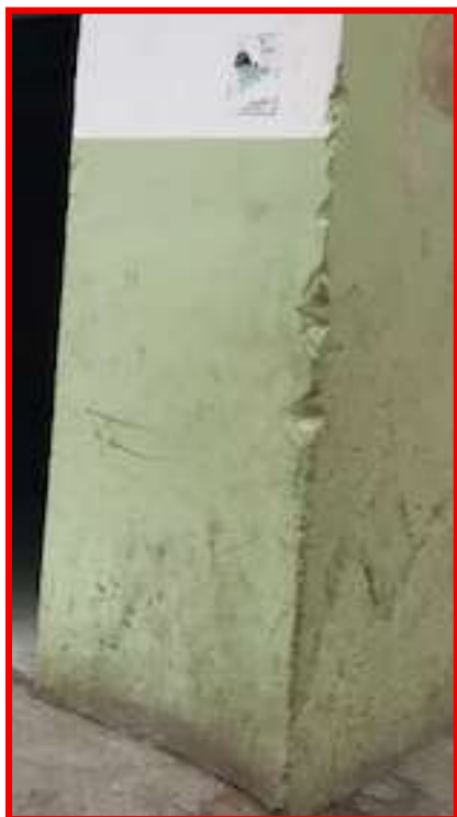
Figura 12 - Detalhe da área externa
