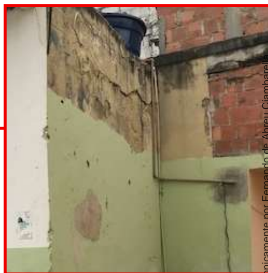
Figura 14 - Detalhe da área externa
