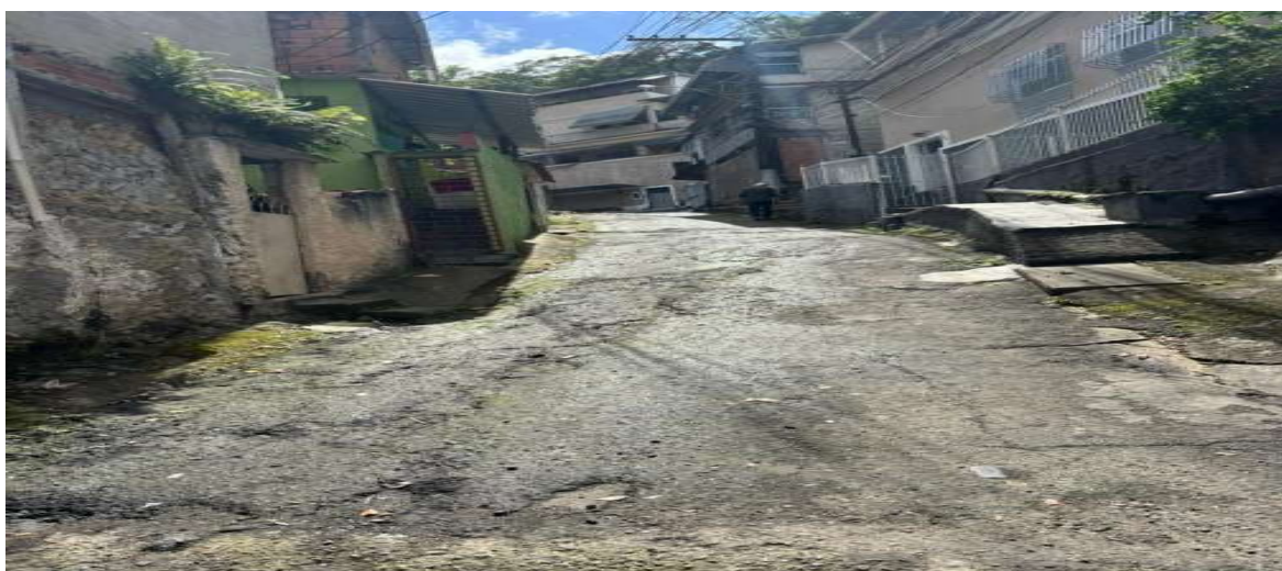
Figura 03: Foto do local de intervenção.
