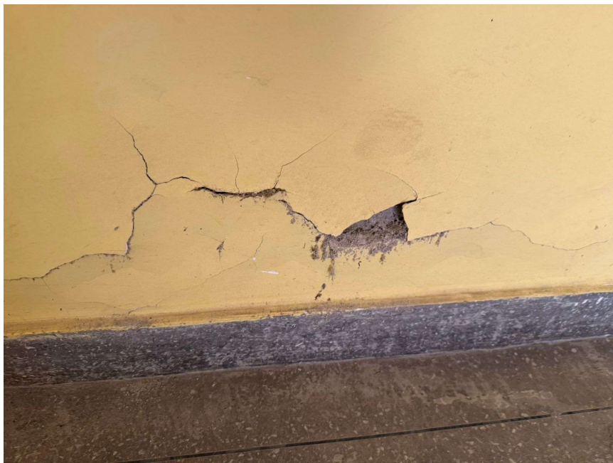
Figura 10 - Paredes com perda de revestimento.
