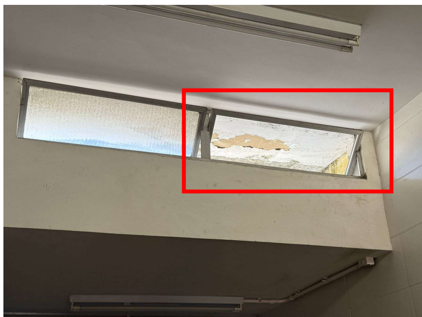
Figura 12 – Janela sem vidro e teto com perda de revestimento e sinais de infiltração.
