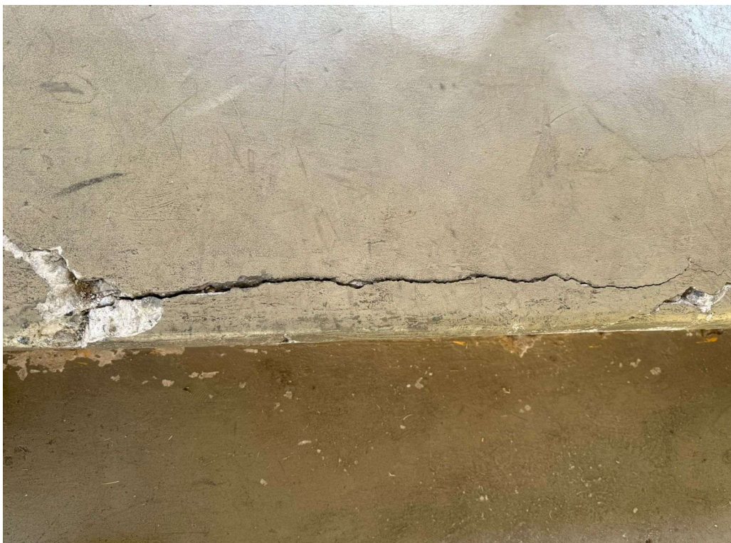
Figura 5 - Danos na arquibancada
