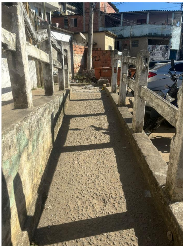
Figura 6 - Rampa de acessibilidade
