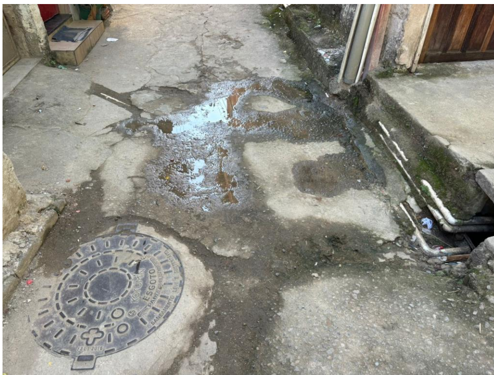
Figura 27 - Área de recapeamento de pavimentação do passeio em concreto
