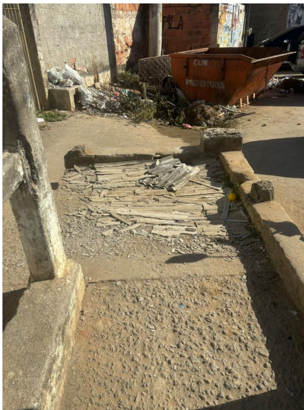
Figura 9 - Patamar da rampa de acesso
