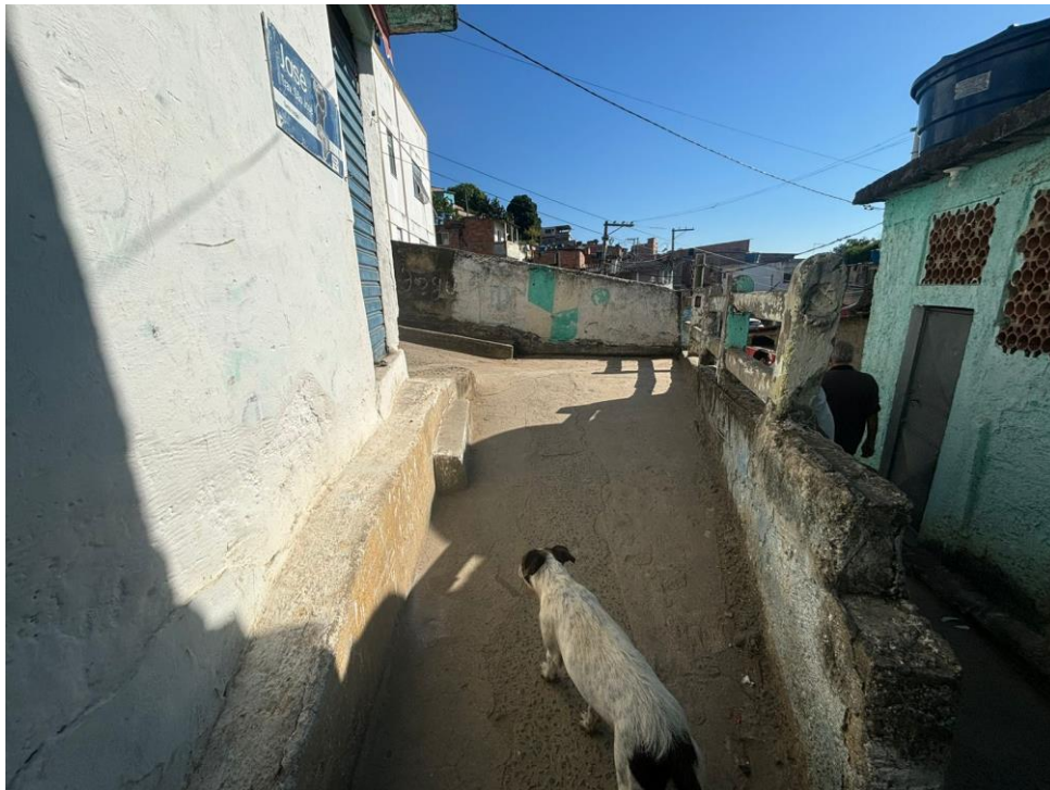
Figura 16 - Rampa de Acesso e Guarda-corpo
