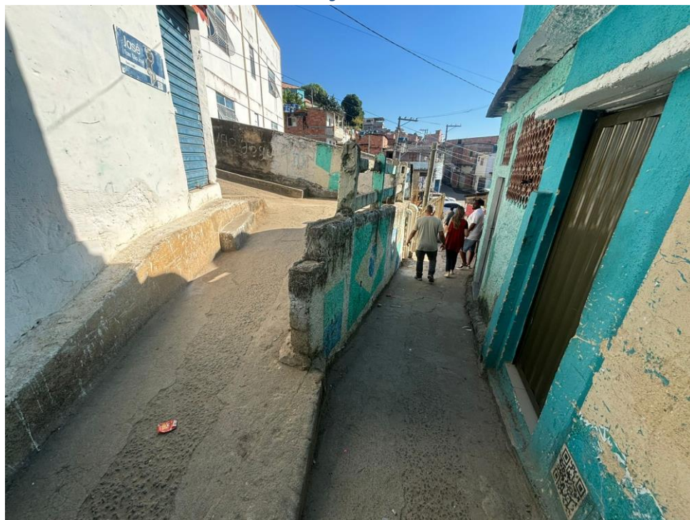
Figura 15 - Rampa de acesso e guarda-corpo existentes
