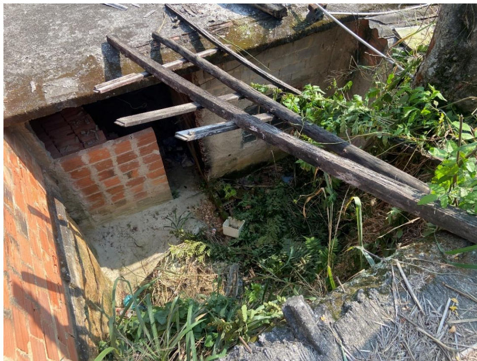
Figura 3 – Vista da casa a jusante de ponto com risco iminente.
