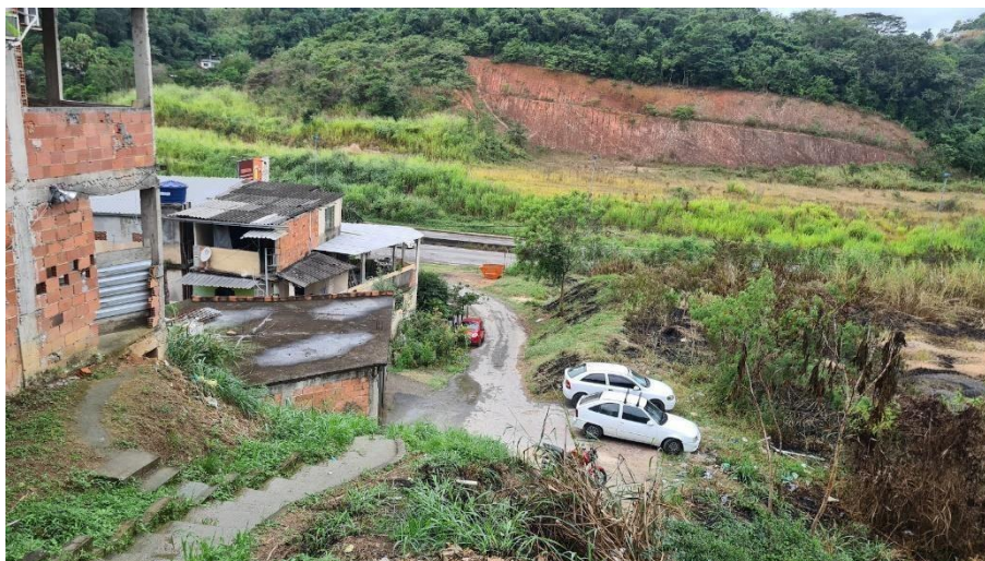
Figura 1 - Estrutura das ruas
