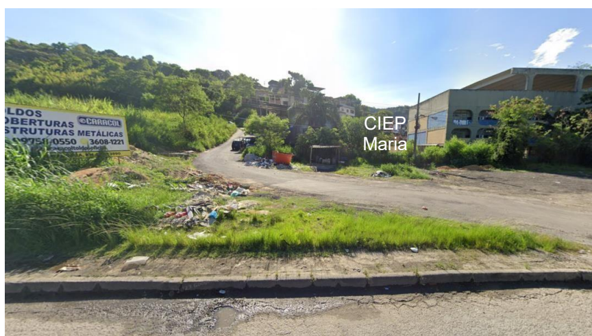
Figura 2 - Estrutura das ruas
