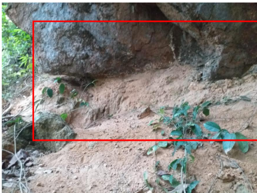
Figura 1 – O local já evidencia deslocamento de material, caracterizando indícios de instabilidade na área, o que pode comprometer a segurança da estrutura e agravar o processo de degradação caso não sejam adotadas medidas de contenção no local.
