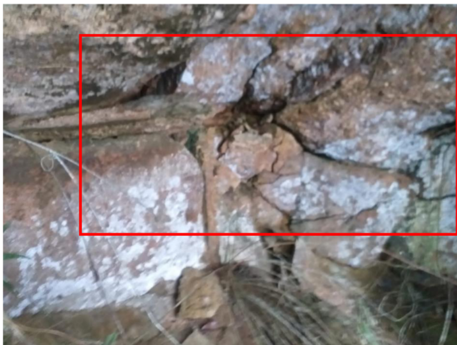
Figura 2 – O bloco rochoso apresenta fissuras visíveis e pontos de desprendimento, evidenciando processos de fragilização e perda de coesão do material, o que aumenta o risco de instabilidade e possíveis deslocamentos em direção à área adjacente.
