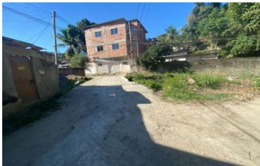
Figura 3 – Acesso da ponte precário
