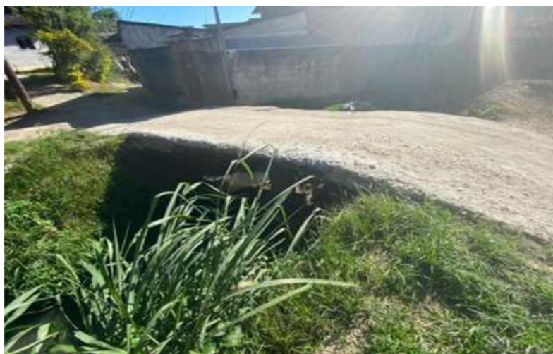
Figura 2 - Estrutura da ponte precária
