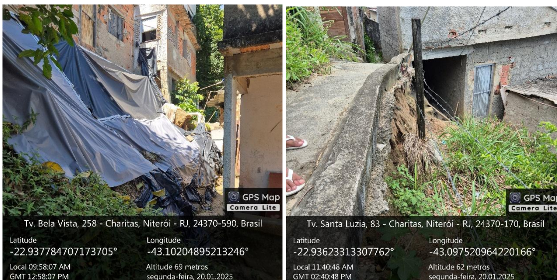
Figuras 02 e 03: Área de intervenção que necessitam de contenção.
