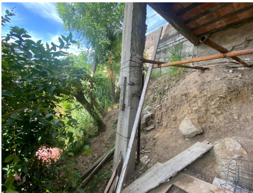
Figura 3 - Vista de um trecho do local.
