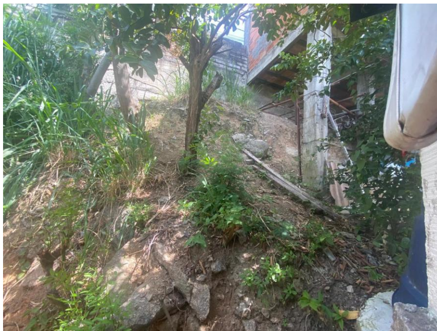
Figura 4 - Vista de um trecho do local.
