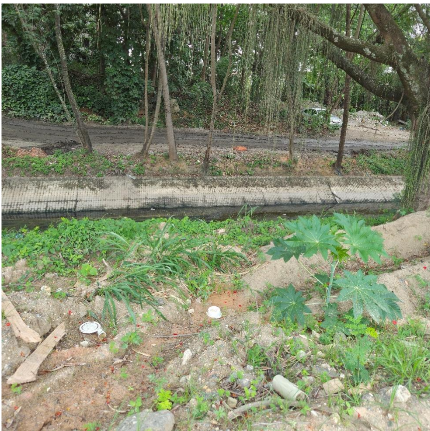
Imagem 4 – Canal localizado próximo a construção da Quadra.
