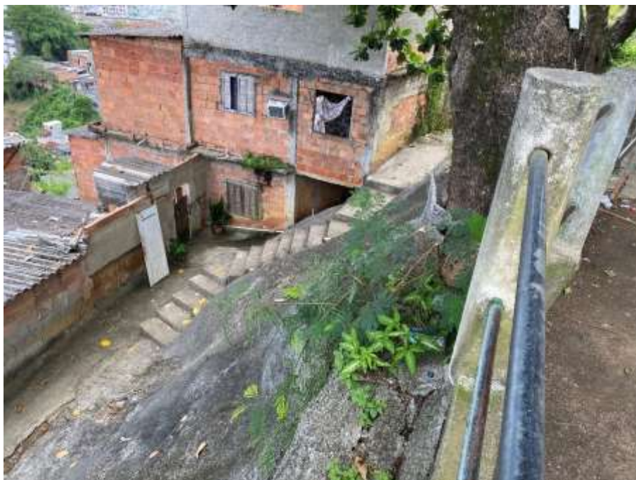
Figura 9 – Revitalização de escadarias através de instalação de guarda-corpos
