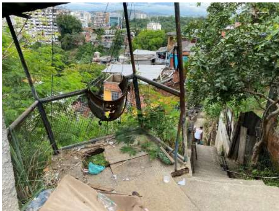
Figura 1 – Melhorias de acesso (escadarias)
