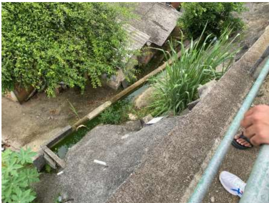
Figura 6 – Recuperação de calhas de drenagem
