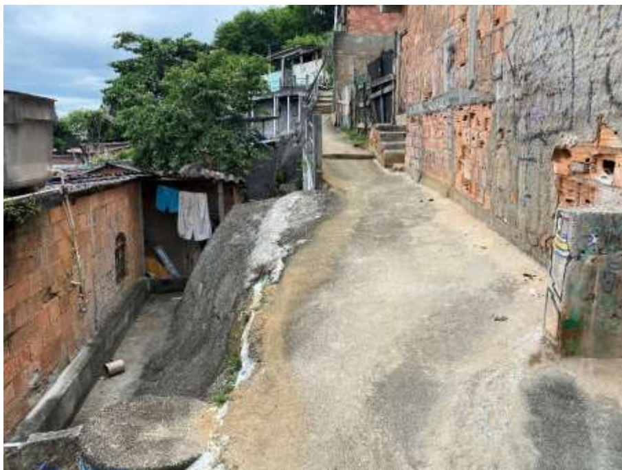
Figura 4 – Instalação de guarda-corpos e contenções
