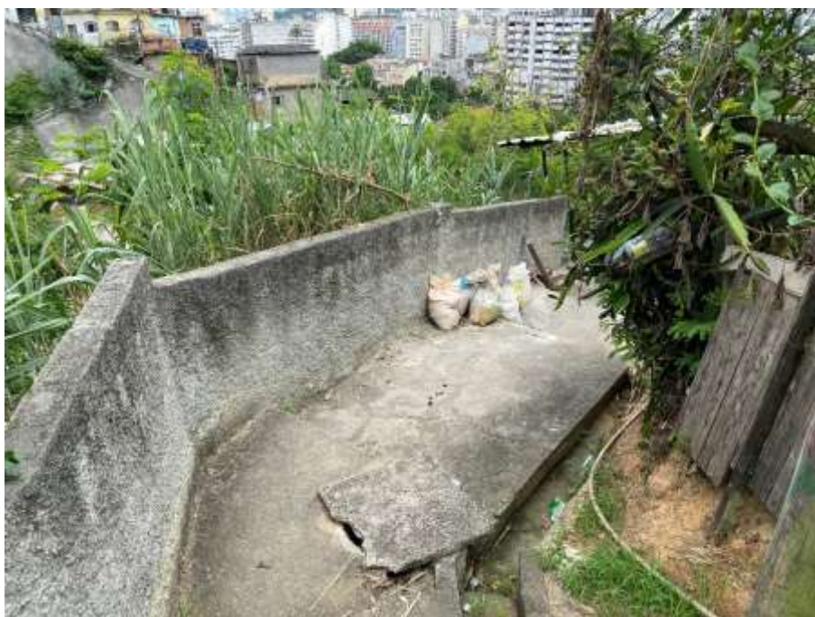
Figura 2 – Revitalização de acessos e drenagem
