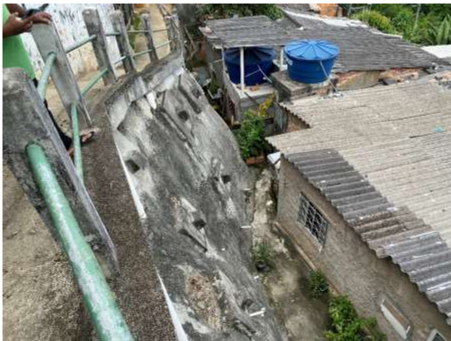
Figura 8 – Recuperação de contenções e drenagem
