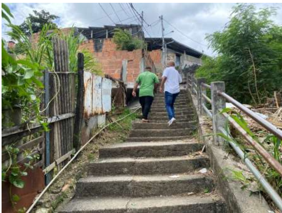
Figura 3 – Recuperação de guarda-corpos
