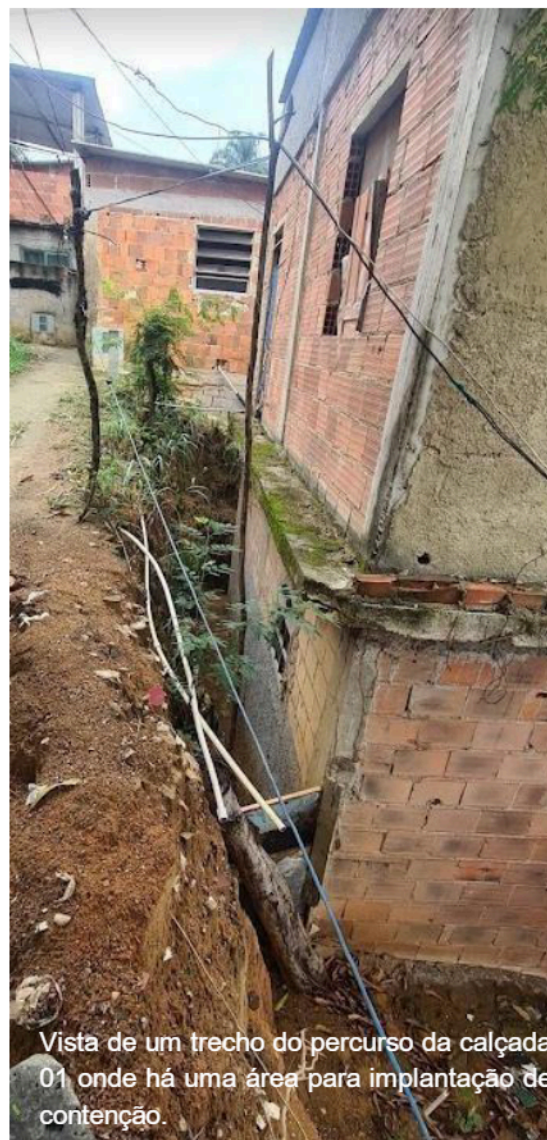
Vista de um trecho do percurso da calçada 01 onde há uma área para implantação de contenção.
