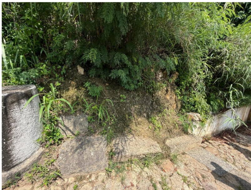
Figura 2 - Trecho do talude a ser estabilizado
