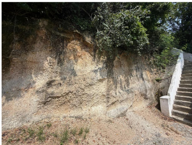
Figura 3 - Trecho do talude a ser estabilizado
