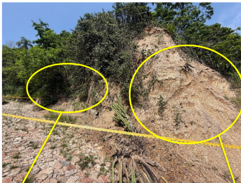
Figura 4 - Trecho inicial do talude a ser estabilizado
