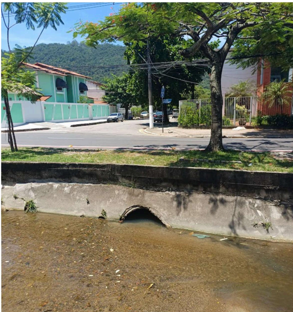
Figura 3 - Assoreamento no deságue da galeria da Rua Padre Natuzzi
