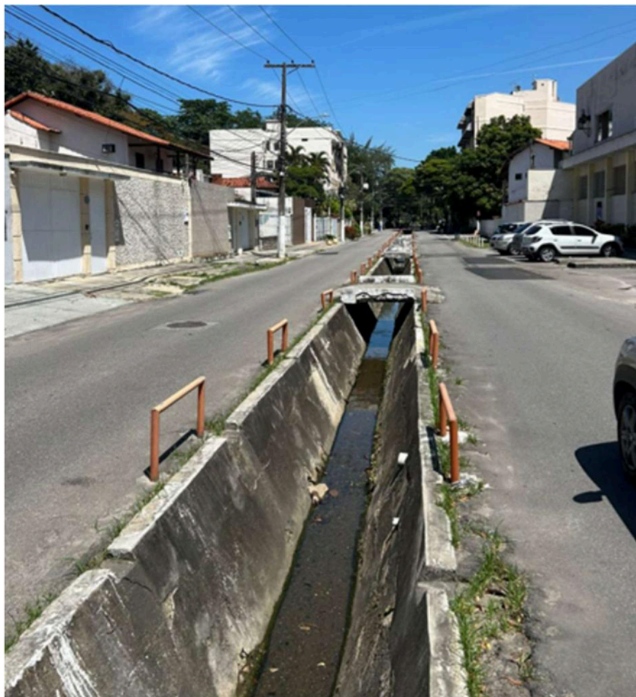
Figura 2 - Canal de drenagem da Rua Taubaté
