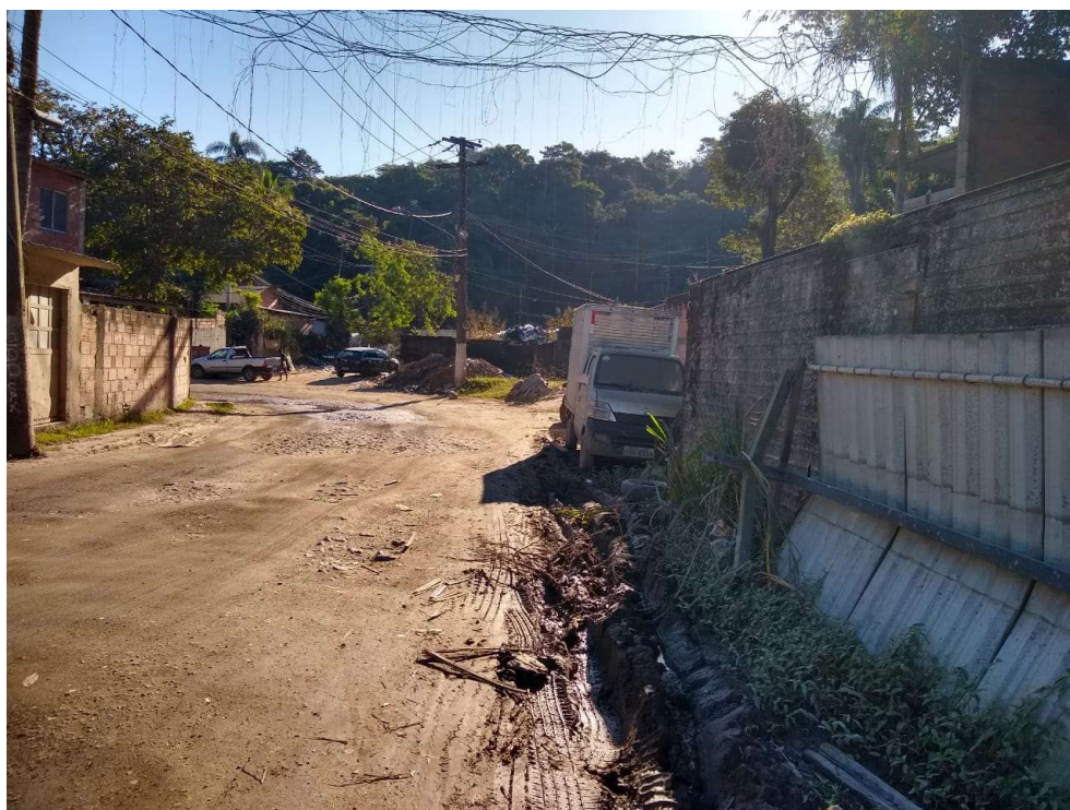
Figura 9 – Via sem pavimentação Adequada
