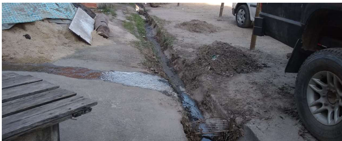
Figura 5 - Presença de vala a céu aberto e drenagem precária
